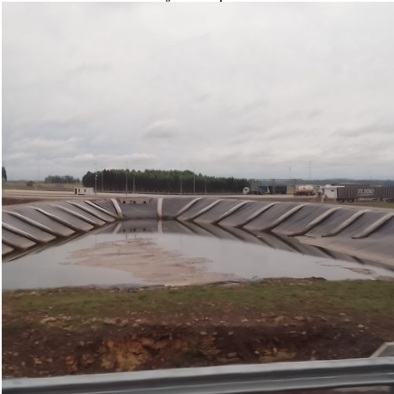
IMAGEM 22- Piscina de tratamento da água utilizada para ser devolvida ao rio.
