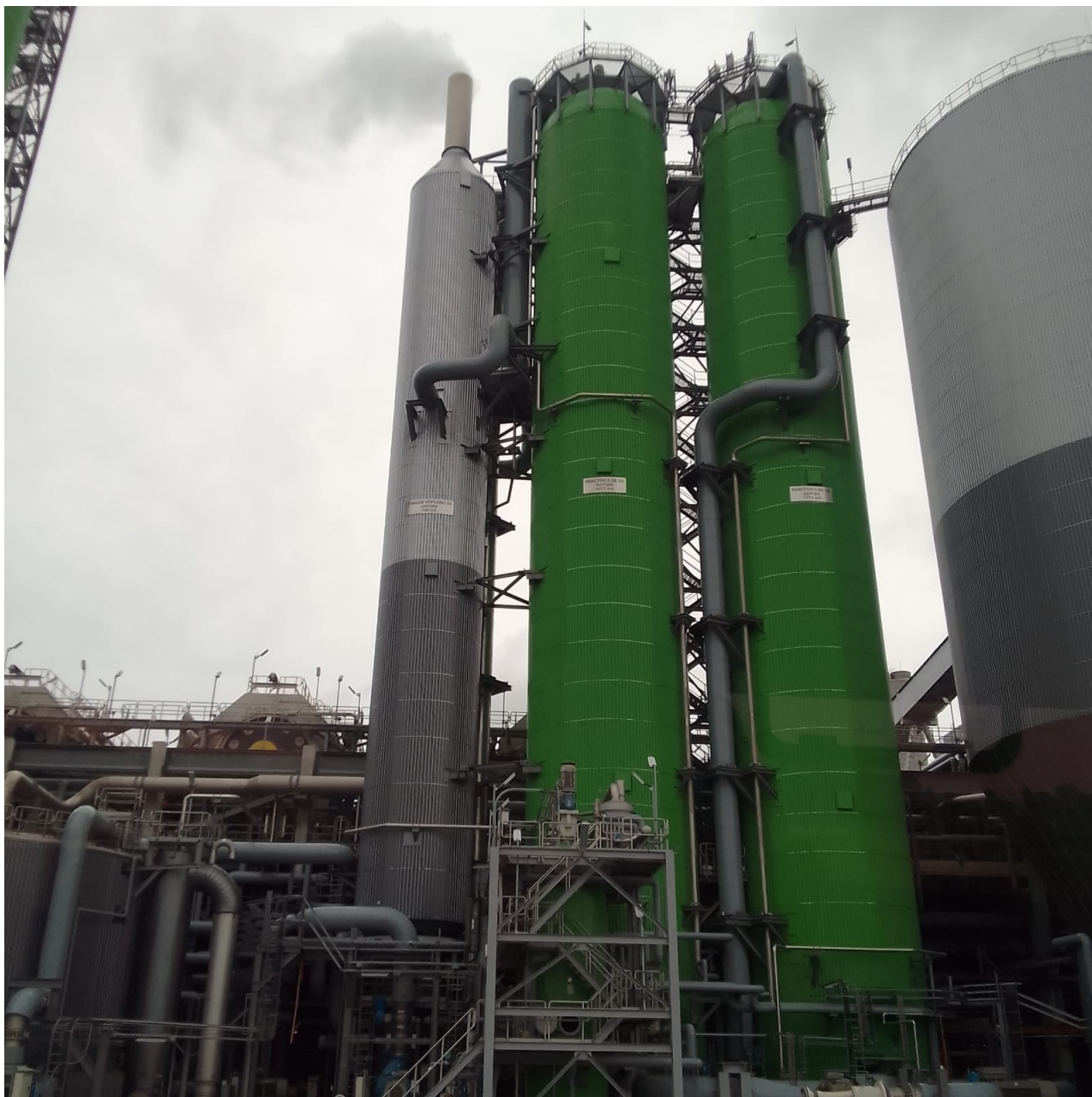
IMAGEM 19- Linha de fibra. Embranquecimento da celulose
