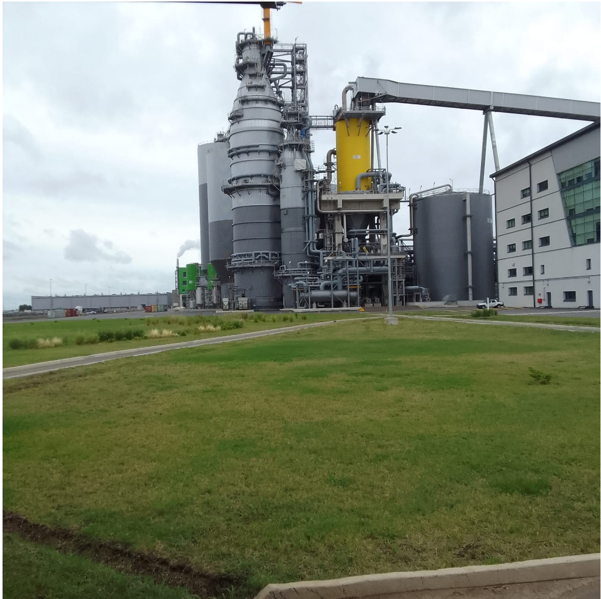
IMAGEM 16- Digestor onde se extrai a celulose da madeira
