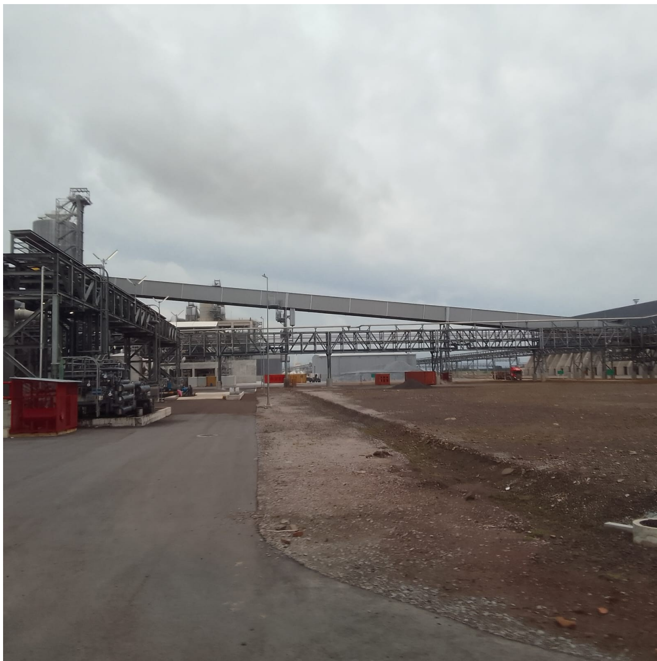
IMAGEM 15- Linhas transportadoras dos chips que ingressam a linha de fibra
