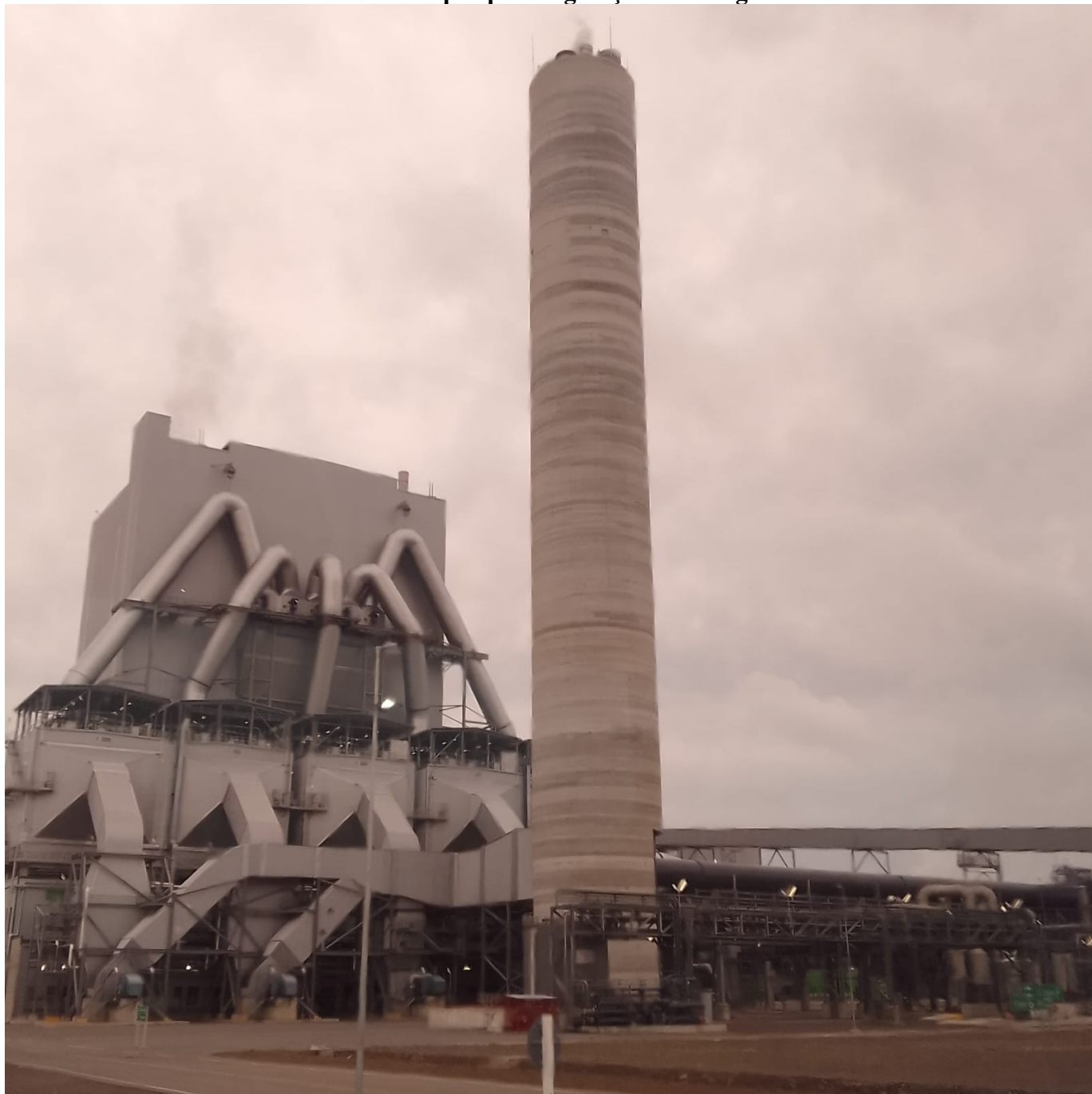
IMAGEM 23- Chimenea de vapor para a geração de energia
