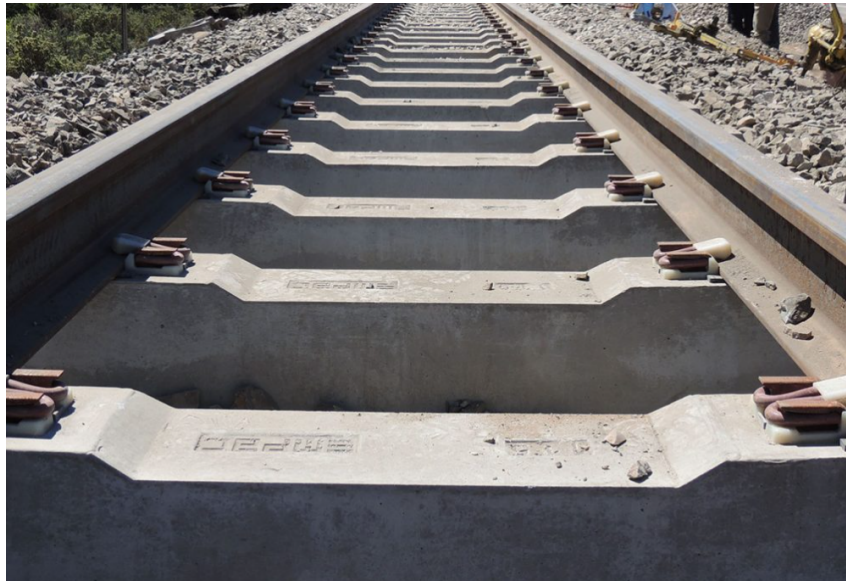
Figura 5 – Dormente Monobloco de Concreto.
