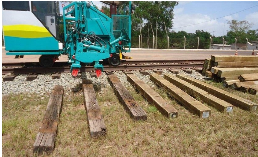
Figura 4 – Substituição dos dormentes de madeira na via.
