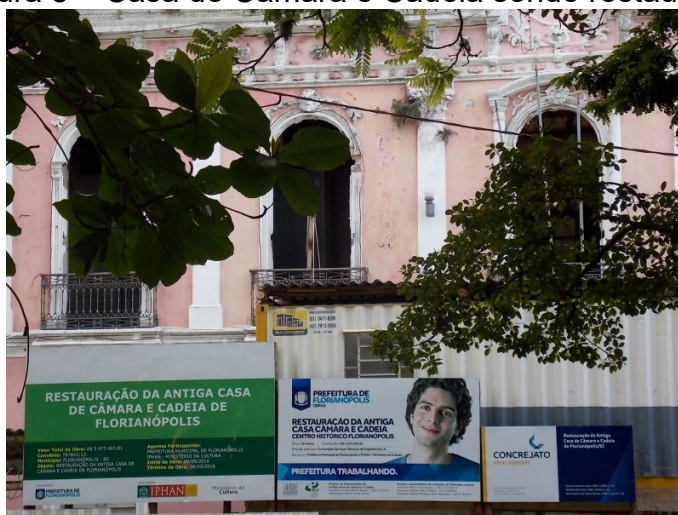
Figura 5 – Casa de Câmara e Cadeia sendo restaurada
