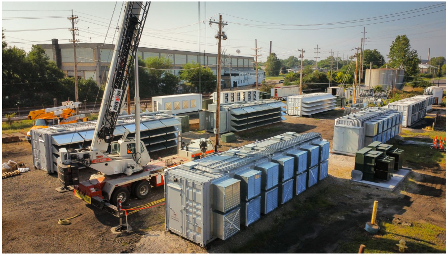
Figura 4 – Data Center da Arthur Mining
