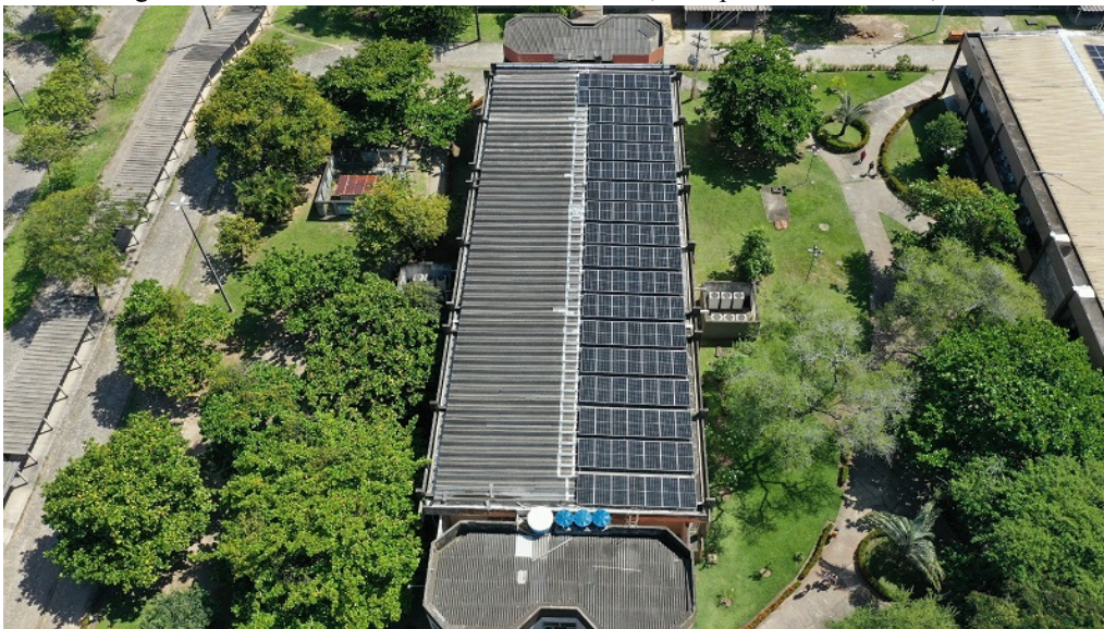
Figura 08 - Sistema Fotovoltaico da Didática I, Campus São Cristóvão, UFS.
