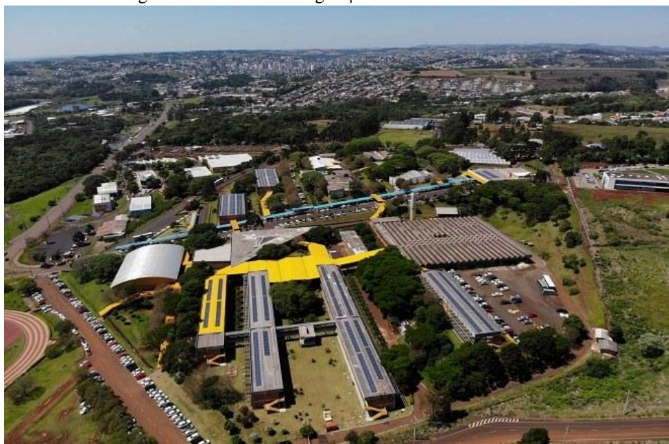
Figura 10 - Usina de Minigeração Fotovoltaica da UTFPR.
