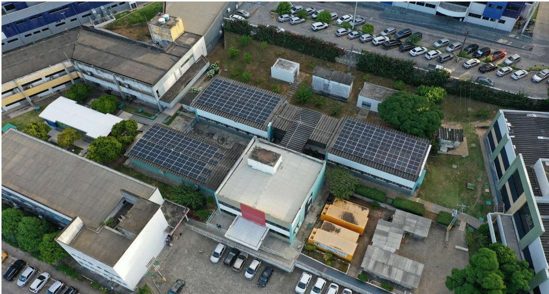
Figura 07 - Sistema Fotovoltaico do Hospital Universitário da UFS.
