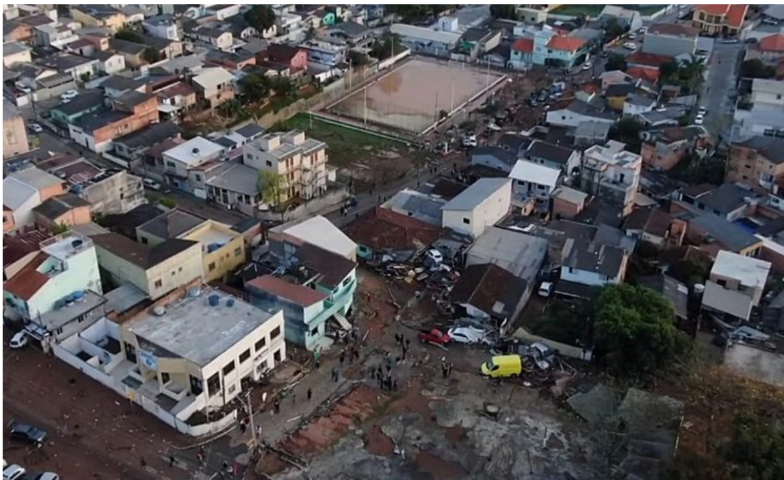
Figura 3 – Rompimento de reservatório da Casan em Florianópolis - SC
