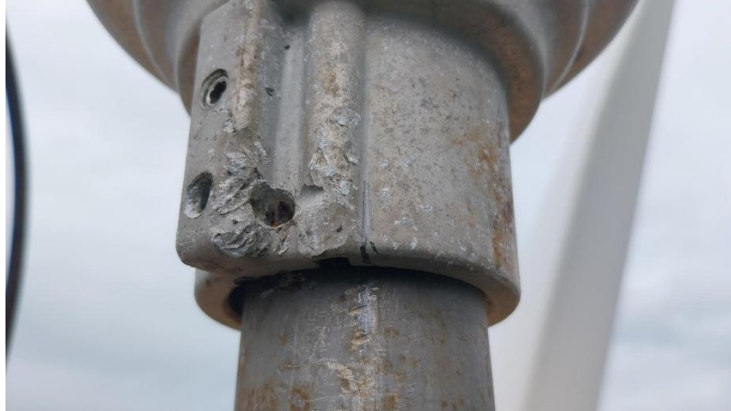
Figura 28 – Suporte do anemômetro: marcação do passe no colar de fixação.
