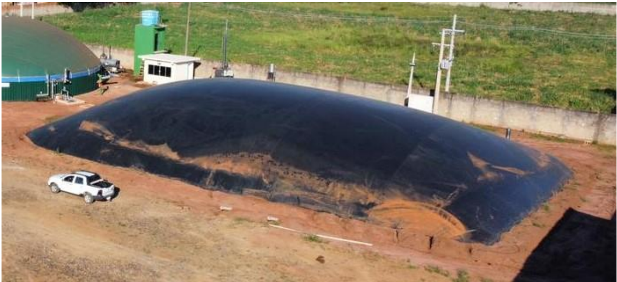
Figura 2 – Reator do tipo BLC
