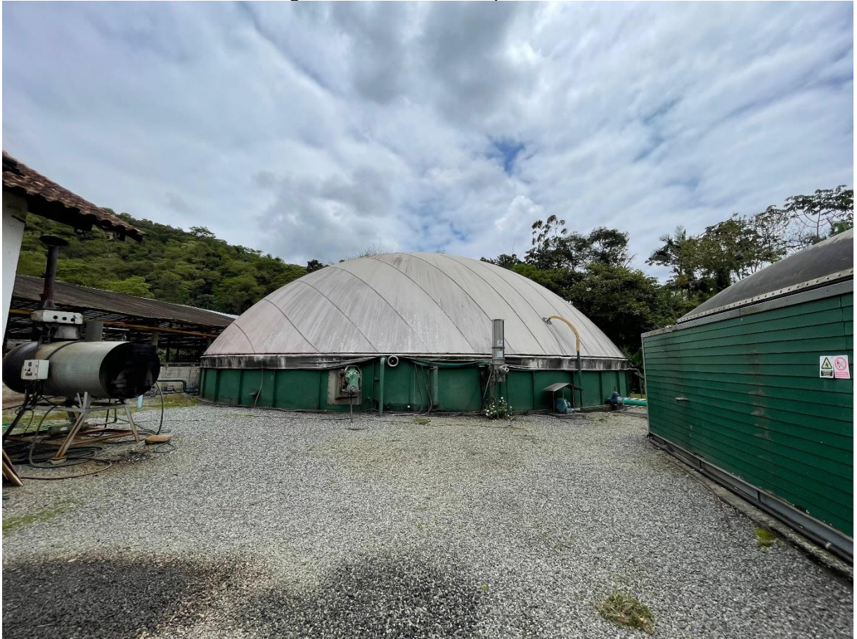
Figura 3 – Reator do tipo CSTR
