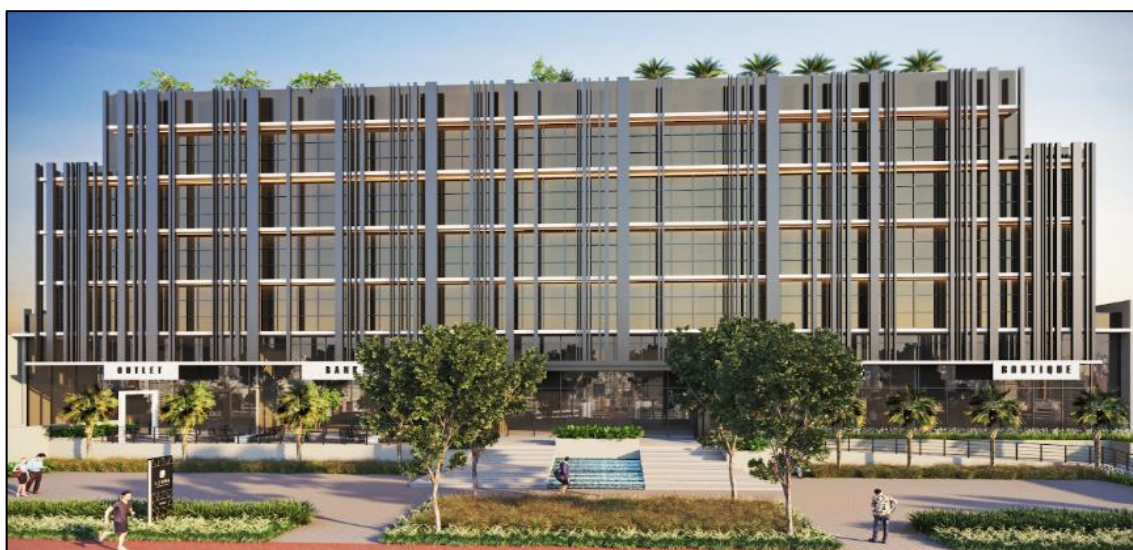
Figura 1 - Fachada frontal da edificação.
