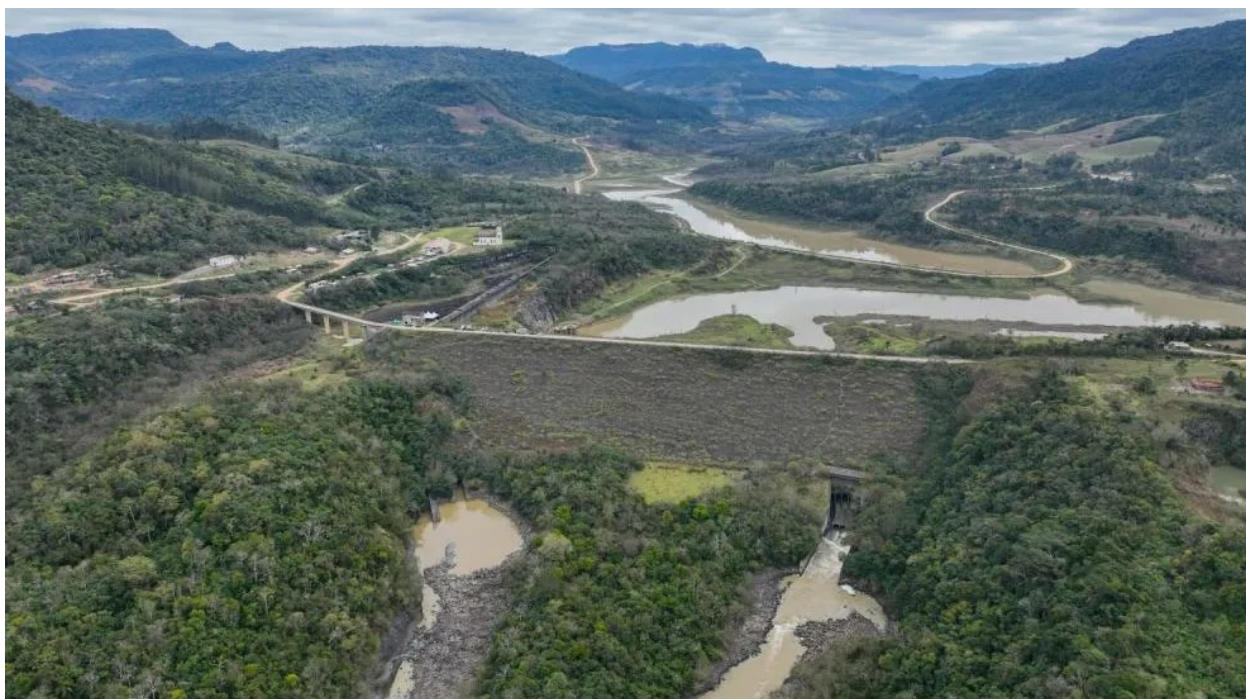
Figura 35 - Imagem aérea da barragem norte
