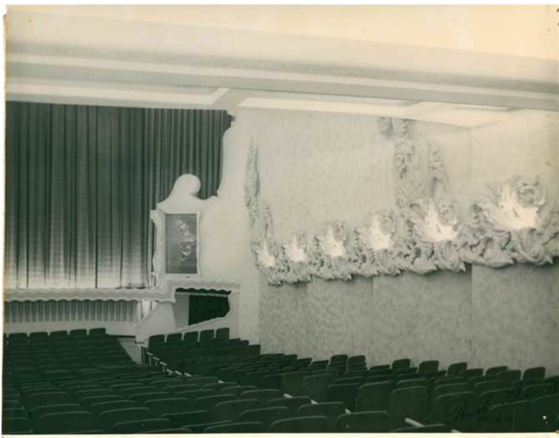
Figura 10 - Elementos decorativos nas paredes laterais do cinema.
