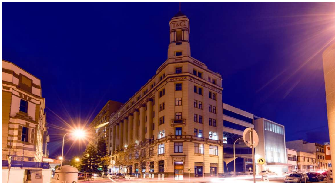
Figura 31 - Edifício T&G na cidade de Newcastle, estado de New South Wales, Austrália.
