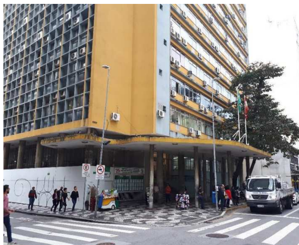
Figura 3 - Esquina Edifício das Diretorias, centro de Florianópolis- SC.
