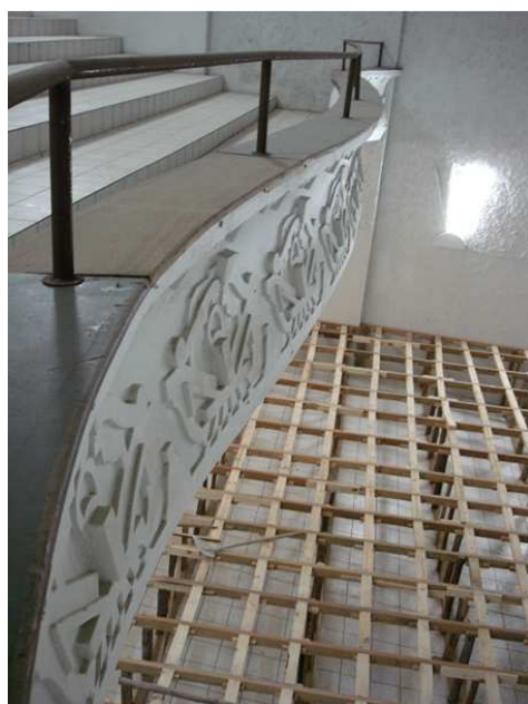
Figura 12 - Mural feito por Franklin Cascaes no guarda corpo do mezanino
