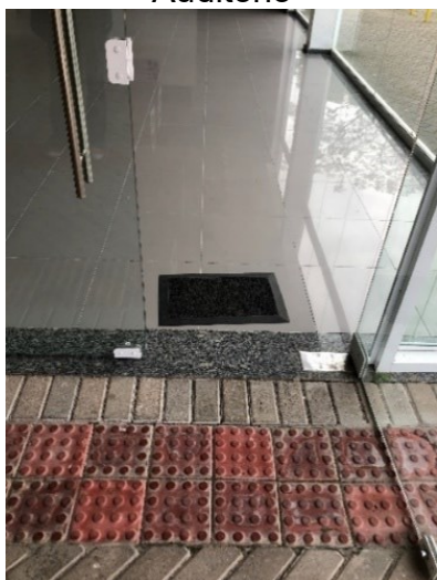
Figura 91 Porta de acesso ao Foyer do Auditório
