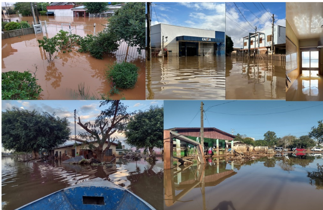
Figura 26 - Área urbana totalmente inundada
