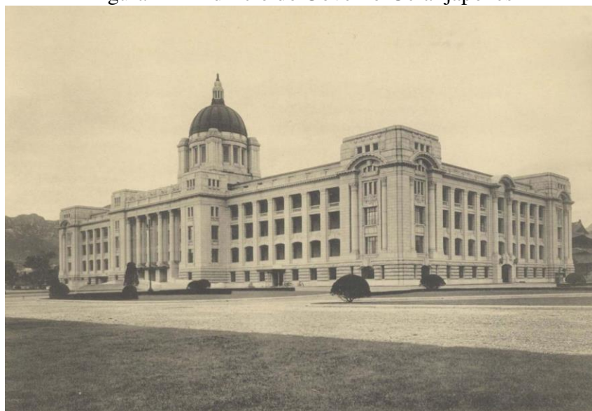
Figura 11 – Edifício do Governo-Geral japonês
