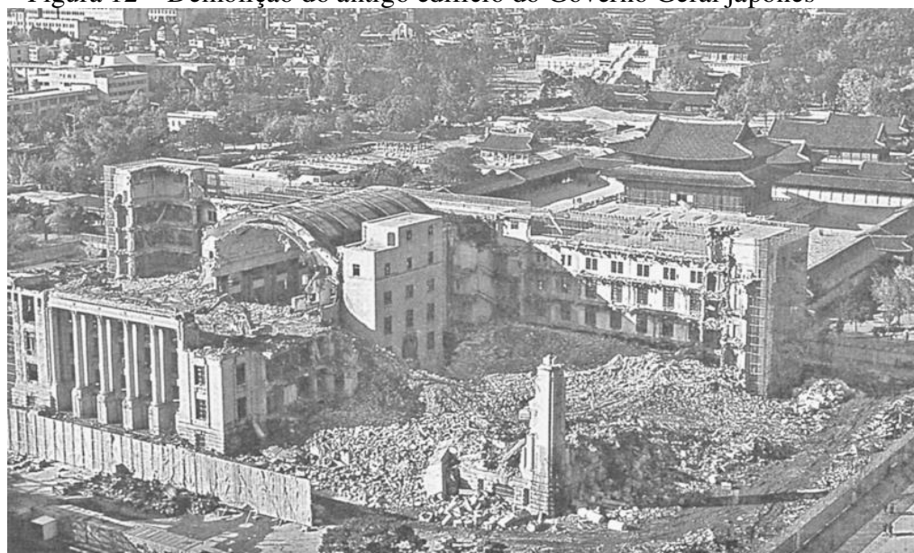
Figura 12 – Demolição do antigo edifício do Governo Geral japonês
