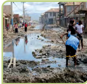
Falta de infraestrutura básica (saneamento, drenagem, transporte).
