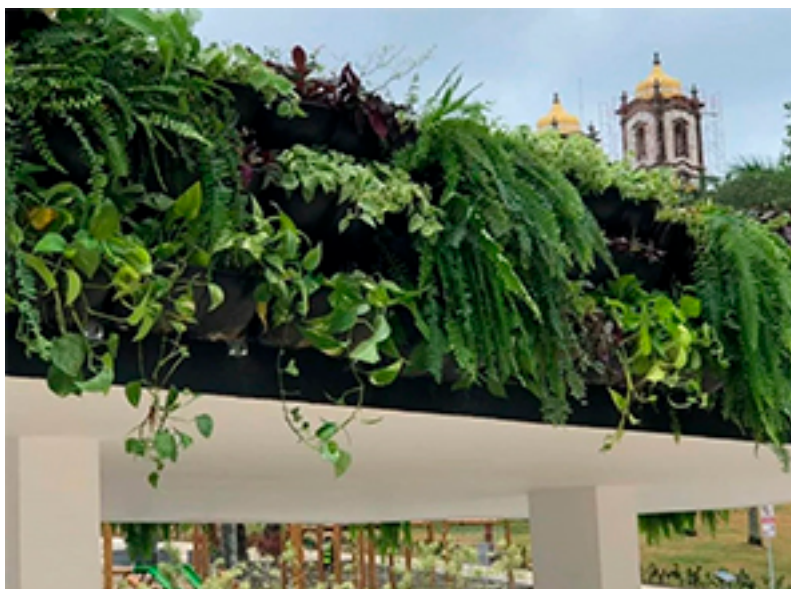
Telhado Verde em Salvador, BA.
