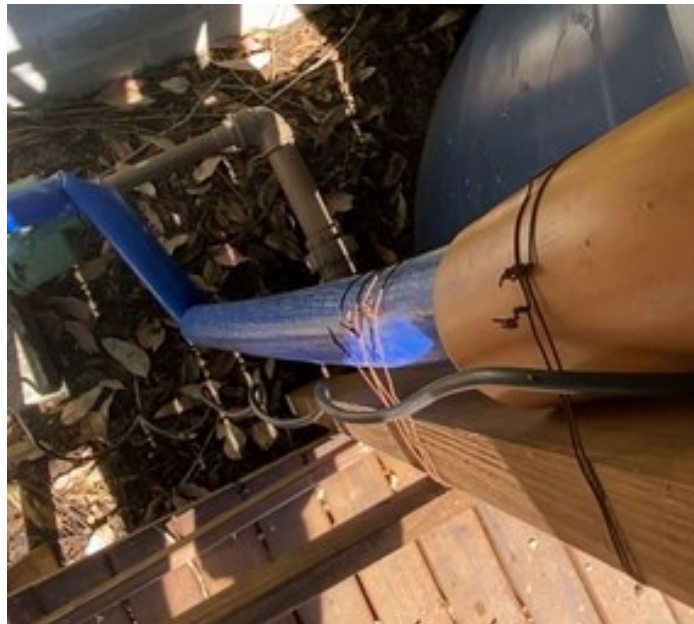
Figura 32: Imagem fotográfica capturada durante a ação de adaptação provisória no sistema de bombeamento de alimentação de lodo nos módulos WCL TS .
