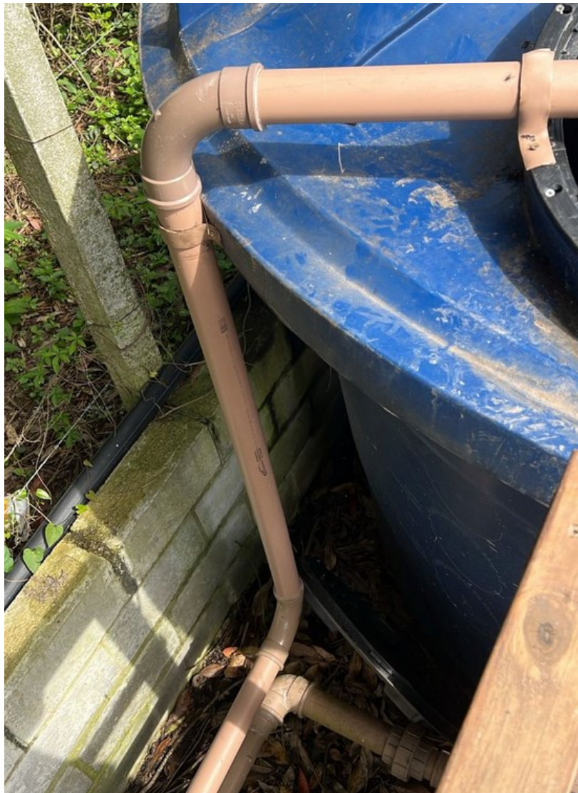
Figura 34: Imagem fotográfica capturada evidenciando o ajuste final na tubulação do sistema de bombeamento/alimentação de lodo séptico bruto nos módulos WCL TS .
