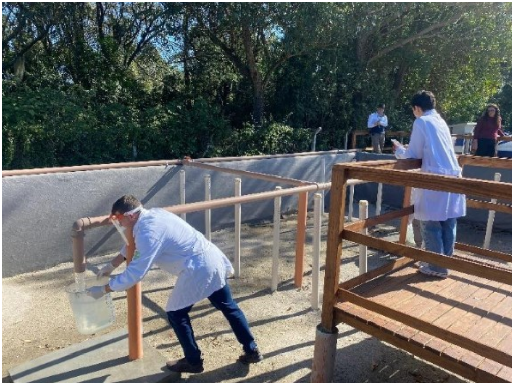
Figura 29 Imagem fotográfica capturada durante a execução dos testes hidráulicos de vazão de alimentação junto aos módulos WCL_{TS} componentes da UGL_{TS} .
