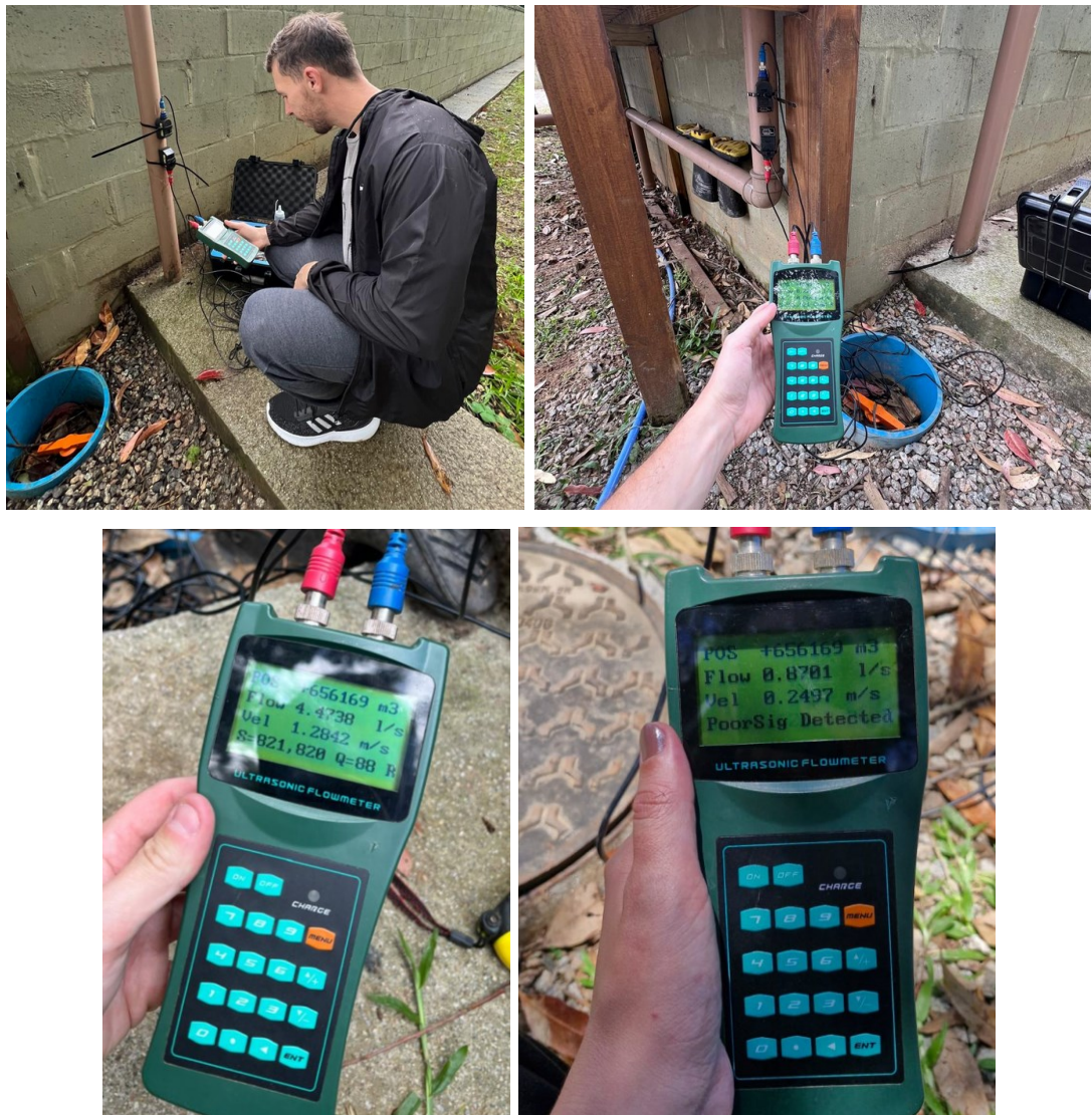
Figura 37: Imagem fotográfica representativa da realização dos testes de vazão com equipamento digital Handheld Ultrasonic Flow Meter .
