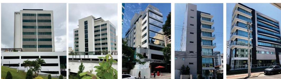
Figura 7 - Fotos de alguns edifícios no levantamento de dados in loco .
