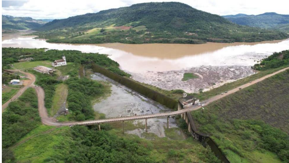
Figura 05: Imagem da barragem Norte de José Boiteux mostra proporção do nível da água
