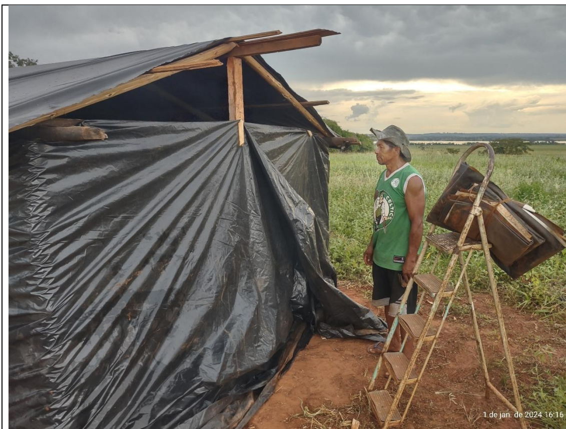
Imagem 27 – Barraco de lona construído duas semanas após a ocupação do antigo mirante.
