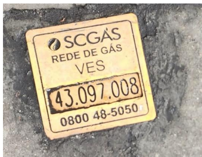
Figura 3.6– Placa com identificação de presença de válvula de gás
