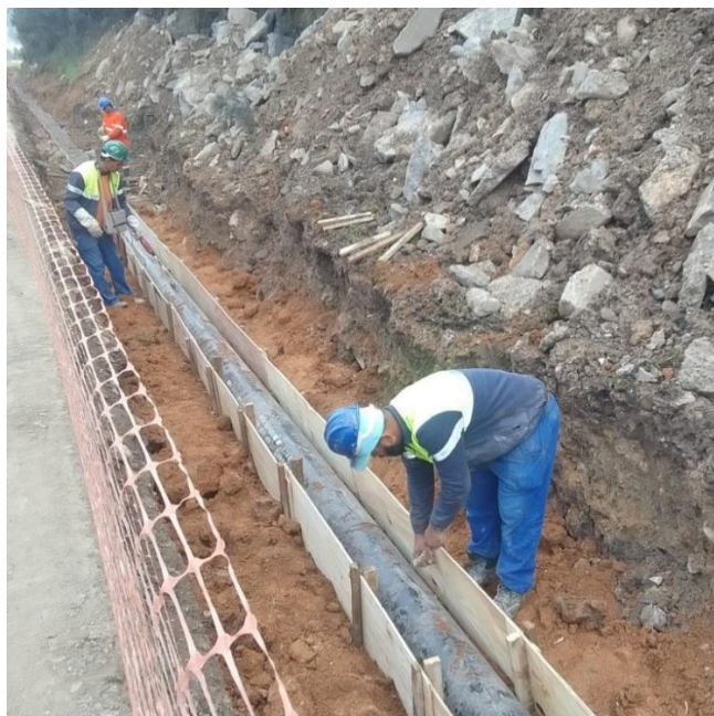
Figura 1.2 – Vala para instalação de tubulação
