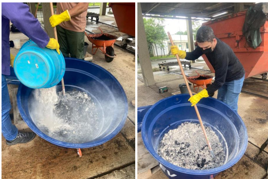
Figura 2. Etapa de caleação do lodo em caixa de 250 L na CAJ.
