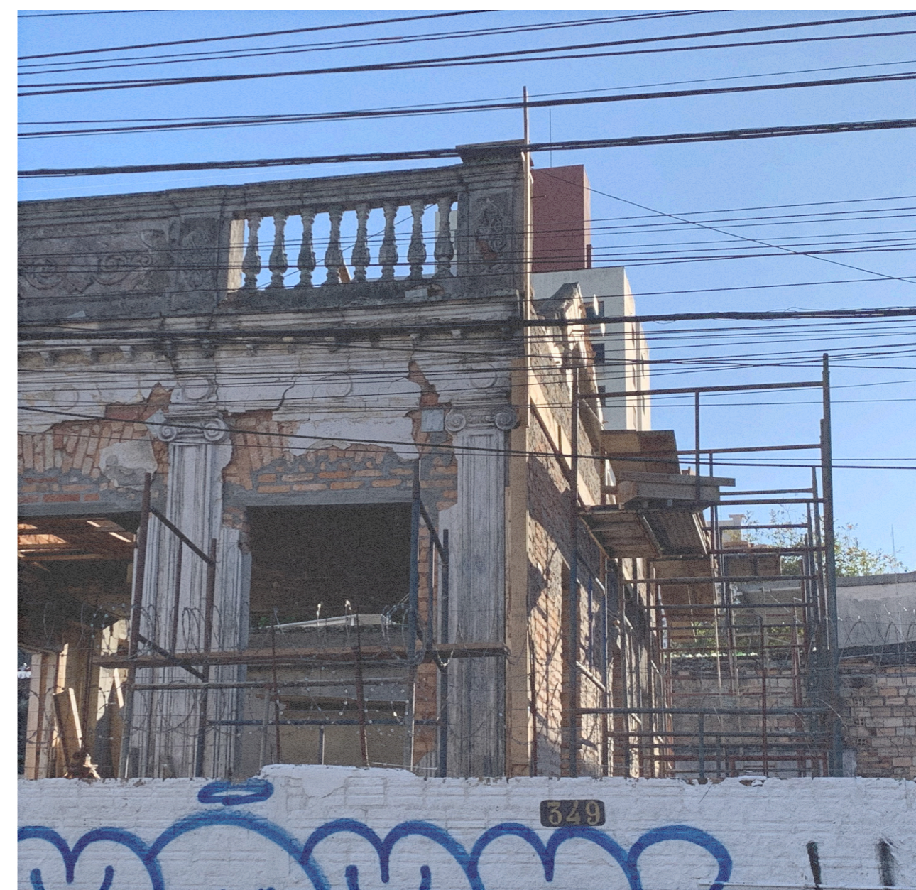
1 mapa do patrimônio nas três quadras 2 edificação na rua Anita Garibaldi, foto pela autora
