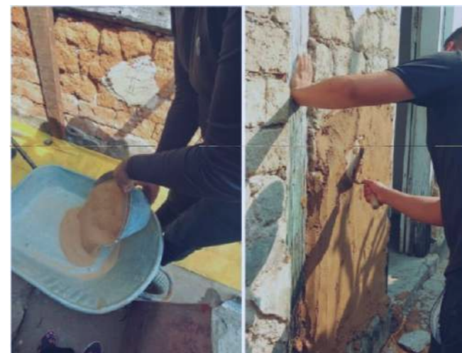
Imagem 6 e 7 - Oficinas de reboco à base de cal, terra e areia Fonte: Souza (2024)
