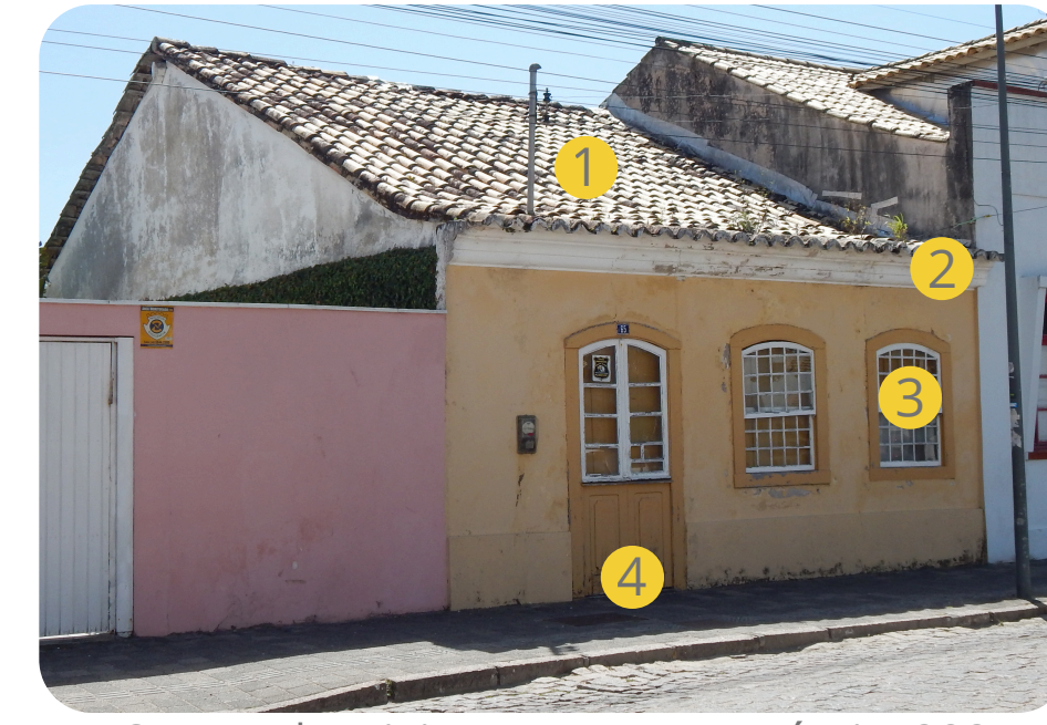
A Casa Ambrozini. Fonte: Acervo próprio, 2025.
