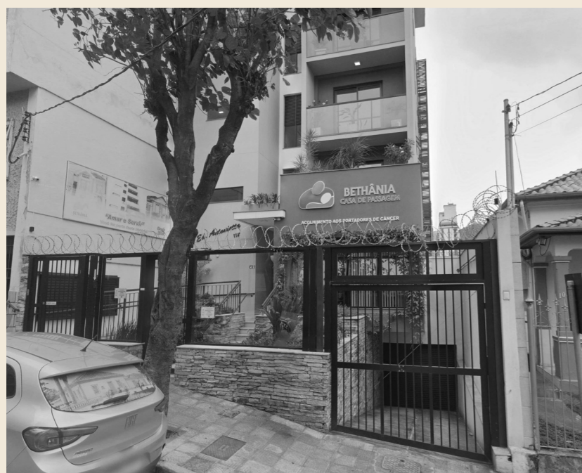
Figura 10: Fachada casa Bethania
