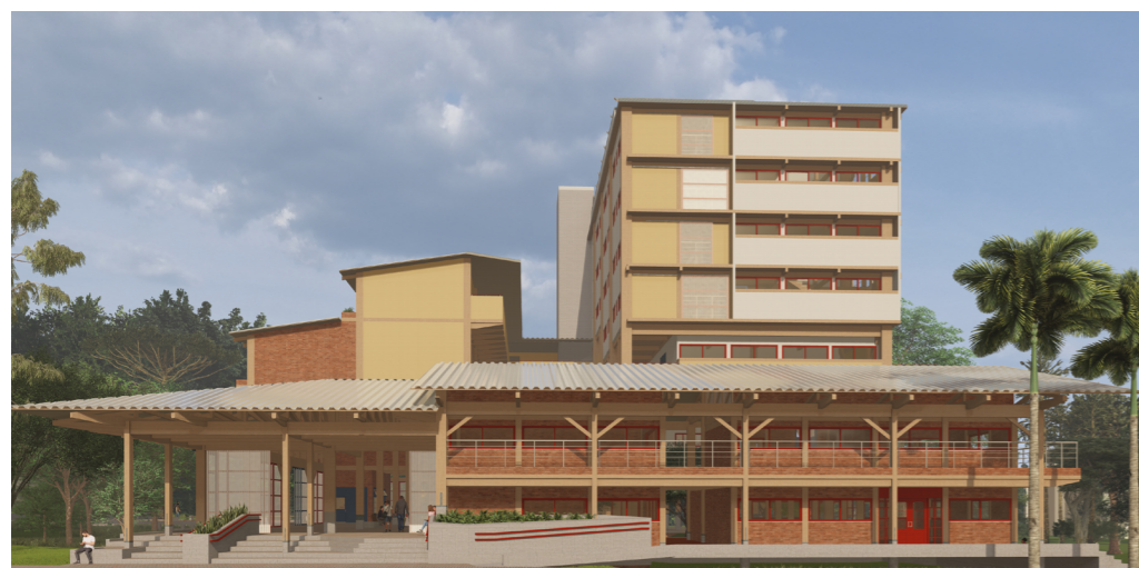
fachada norte, acesso para rua eng. agron. andrei cristian ferreira
