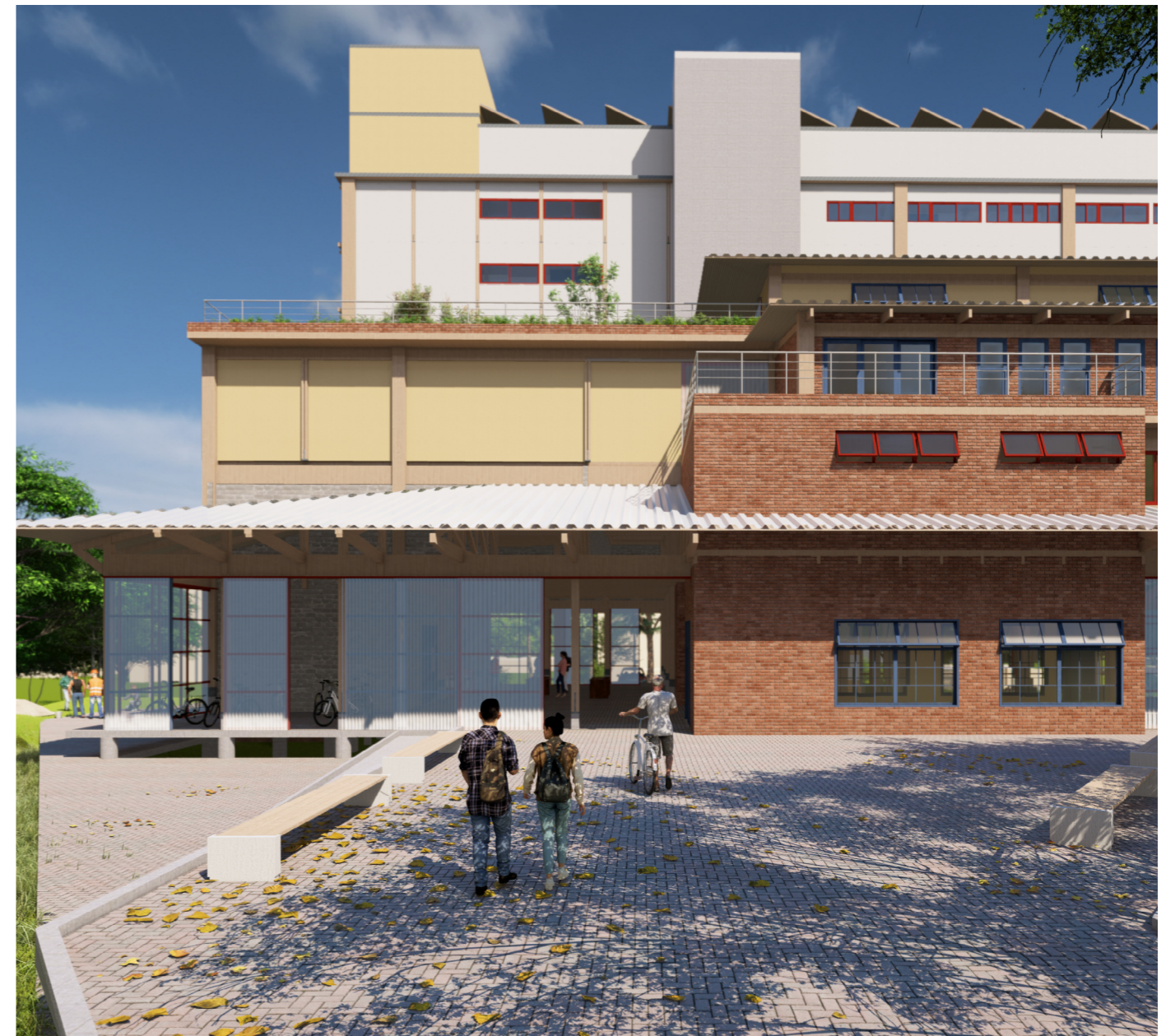
O entorno foi tratado como parte do prédio, num movimento de abertura da universidade para a cidade. Onde o prédio branco se isola, a proposta se abre: um acesso direto à rua dep. Edu Vieira, ligando a ampla calçada e ciclovia diretamente ao prédio, como vemos na renderização acima.
