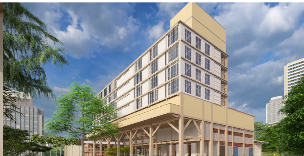
vista ampla da edificação
