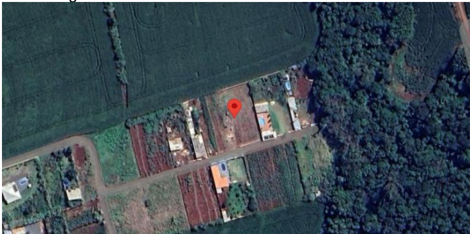
Figura 14 – Vista aérea do terreno da usina em solo
