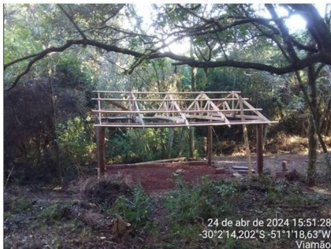
Foto 6. Casa da comunidade em construção.
