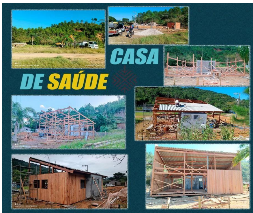
Figura 15 Construção da Texai Renda (casa de saúde) 2024
