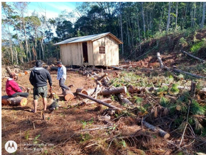
Figura 7 Construção das casas, com a retirada dos pinus, 28/06/2020
