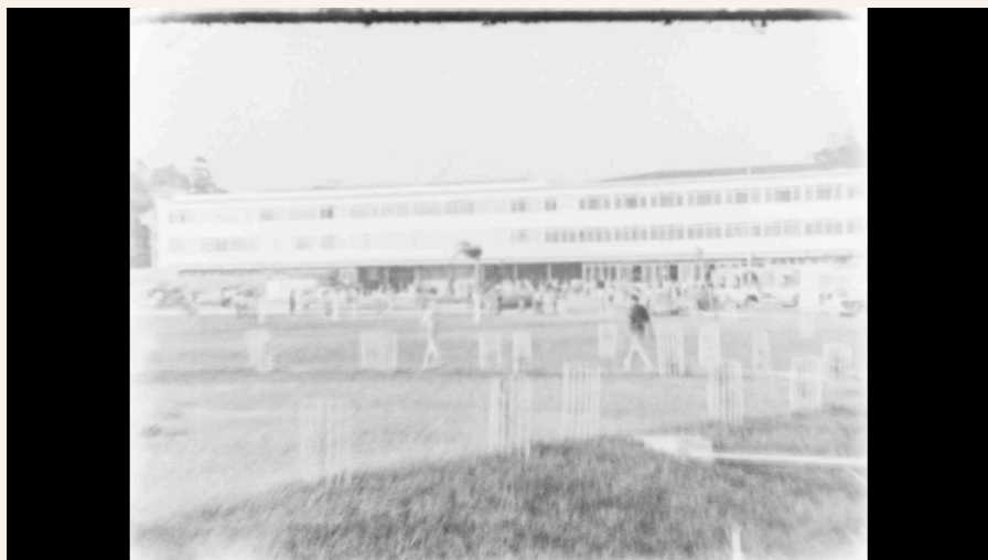
Figura XXVI - Imagem do externo do Bloco A do CCE.
