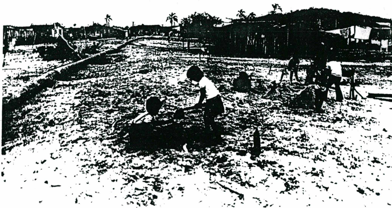
FOTO 6. Crianças brincam na areia do aterro executado. À esquerda, a linha de tubulação da draga.
