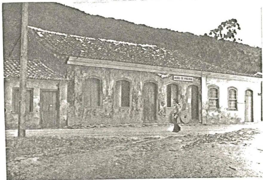
Fig. 83 - Conjunto arquitetônico do Ribeirão da Ilha.
