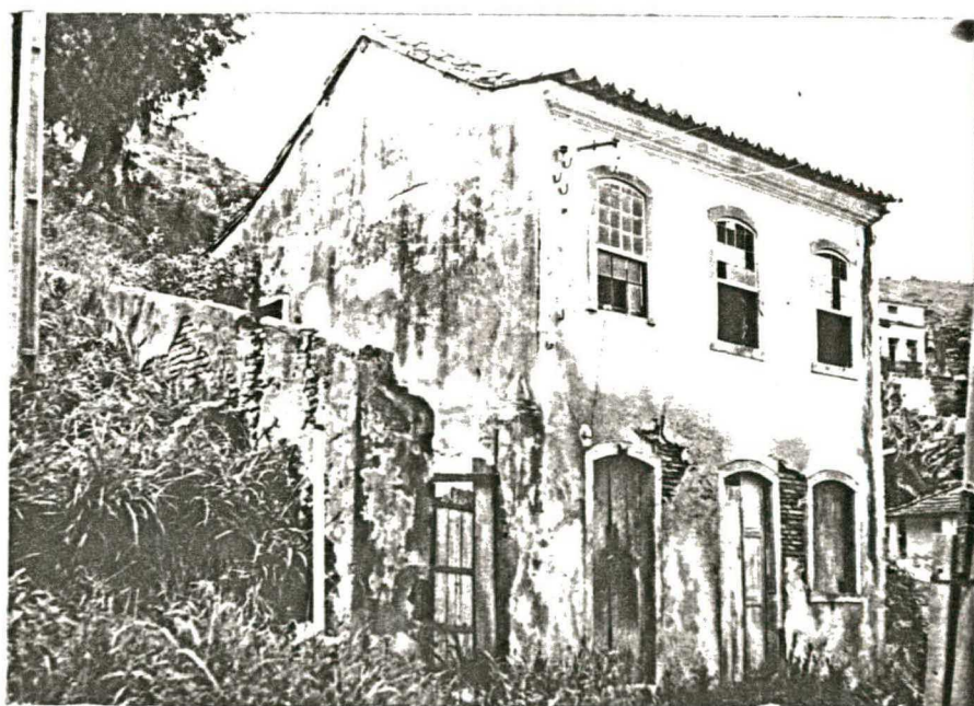
Fig. 94 - Sobrado dos finais do século XVIII, localizado no antigo bairro da Toca e prestes a ser demolido.
