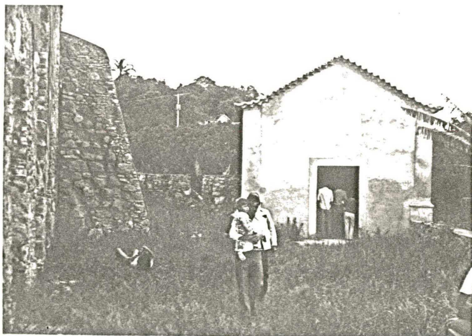
Fig.15 - Fortaleza de São José da Ponta Grossa - Capela restaurada e parte dos contrafor- tes do prédio do Quartel.
