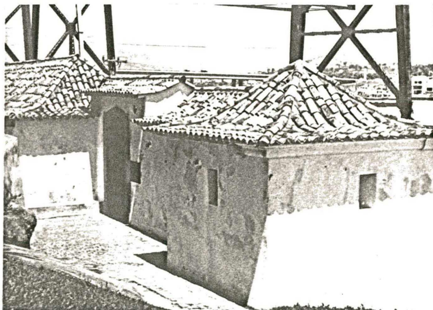
Fig. 31 - Forte de Santana - detalhe da entrada.
