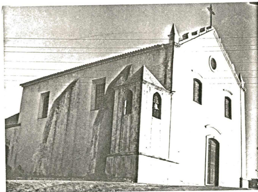
Fig. 55 - Igreja de São Francisco de Paula, distrito de Canasvieiras - Fachada.
