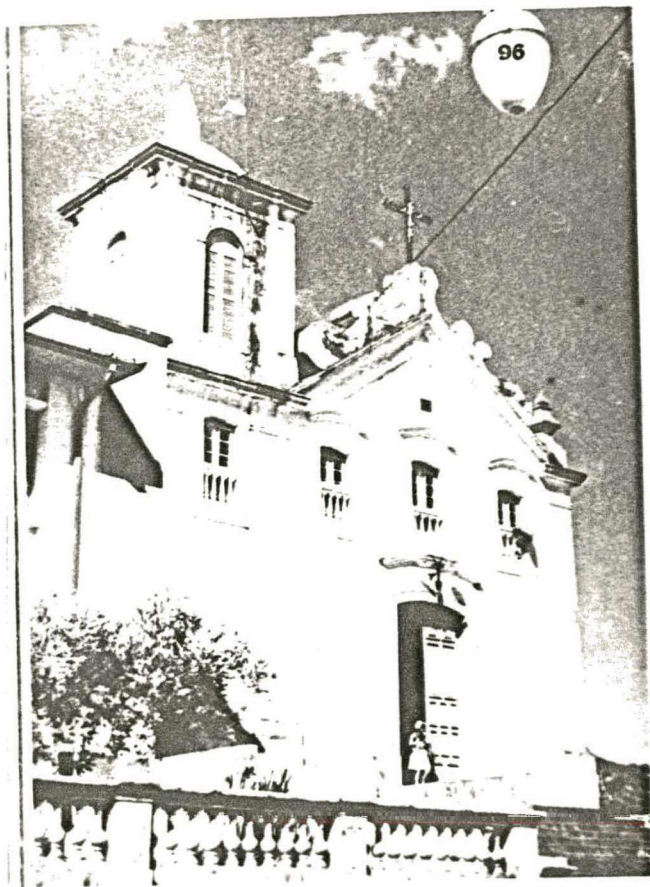
Fig. 56 - Igreja de Nossa Senhora do Rosário e São Benedito, na capital do Estado. Fachada.
