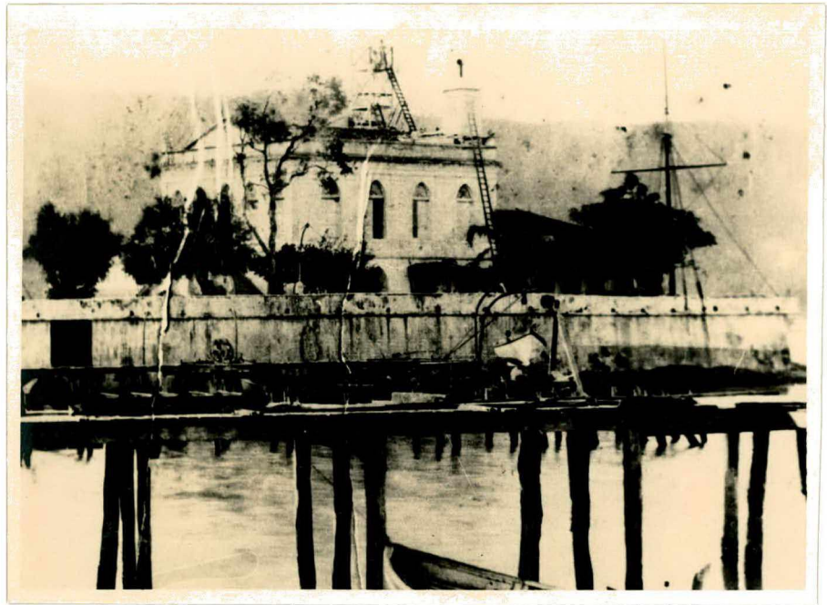
Fig. 35 - Forte de Santa Bárbara - foto da época em que lá funcionava a Capitania dos Portos.
