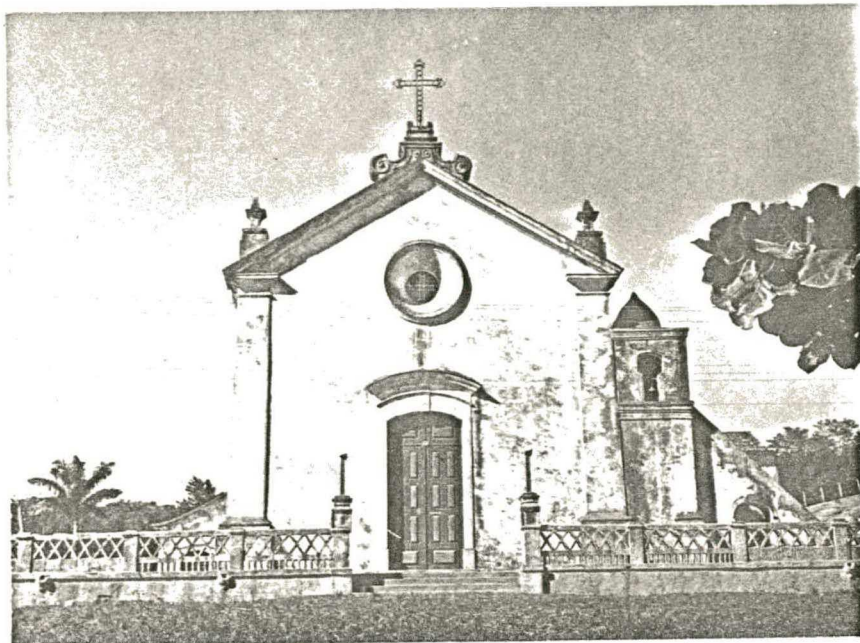
Fig. 54 - Igreja de Nossa Senhora das Necessidades, distrito de Santo Antonio de Lisboa - Fachada.
