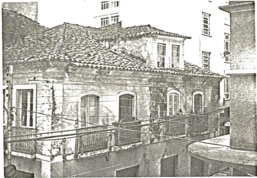
Fig.95 - Antigo Sobrado com trapeira, existente na rua João Pinto, hoje demolido.
