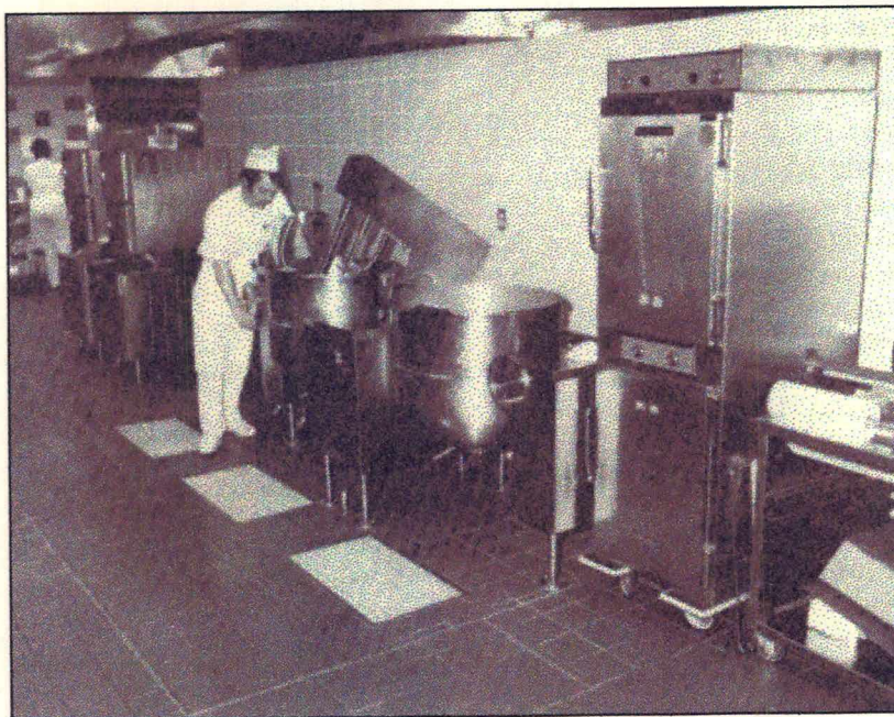
Fig. 3. 9- Equipamentos montados sobre o piso.
