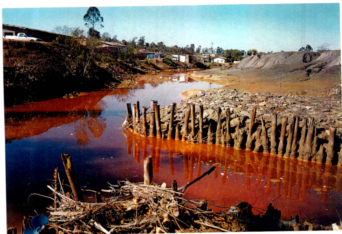
Figura 62: No primeiro plano visualiza-se o desvio realizado por uma carbonífera para tomada de água do rio Sangão, com a finalidade de abastecer a usina de beneficiamento de carvão mineral. No fundo observa-se o depósito de rejeitos piritosos em Área de Preservação Permanente, APP, do rio Sangão. Rio Maina, Criciúma. Agosto/2000. Foto cedida pela FATMA, de autoria de Norberto Cidade
