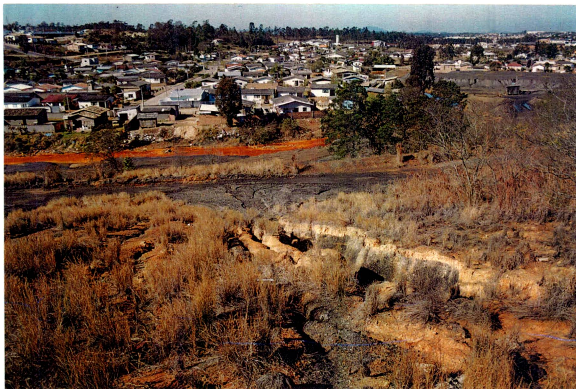
Figura 57: Vista parcial de depósito de rejeitos piritosos, com vários focos erosivos, na área de domínio da mata ciliar do rio Sangão, destacado pela coloração vermelha no fundo do depósito. Na margem esquerda observa-se a Vila Francesa, inserida na paisagem degradada pela mineração. Essa vila foi totalmente construída sobre a deposição de rejeitos, já que originalmente era uma área de banhado. É possível observar também na margem esquerda do rio a deposição de lixo e entulhos. Foto cedida pela FATMA, de autoria de Norberto Cidade. Rio Maina, Criciúma, SC, junho 2000.
