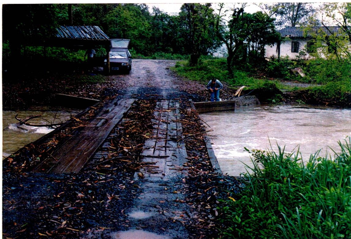
Figura 43: Rio Cedro Alto, em estação de monitoramento avaliada por Santa Catarina (1997d), realizadas duas medidas de vazão: a primeira em período de cheia quando registrou-se 12.236 L/s em 22/10/96 (data da foto) e a segunda em período de estiagem com 433 L/s em 04/12/96. Observa-se a quantidade de detritos transportados pelas águas. Foto cedida pelo IPAT/UNESC, de autoria de Eduardo Nosse.
