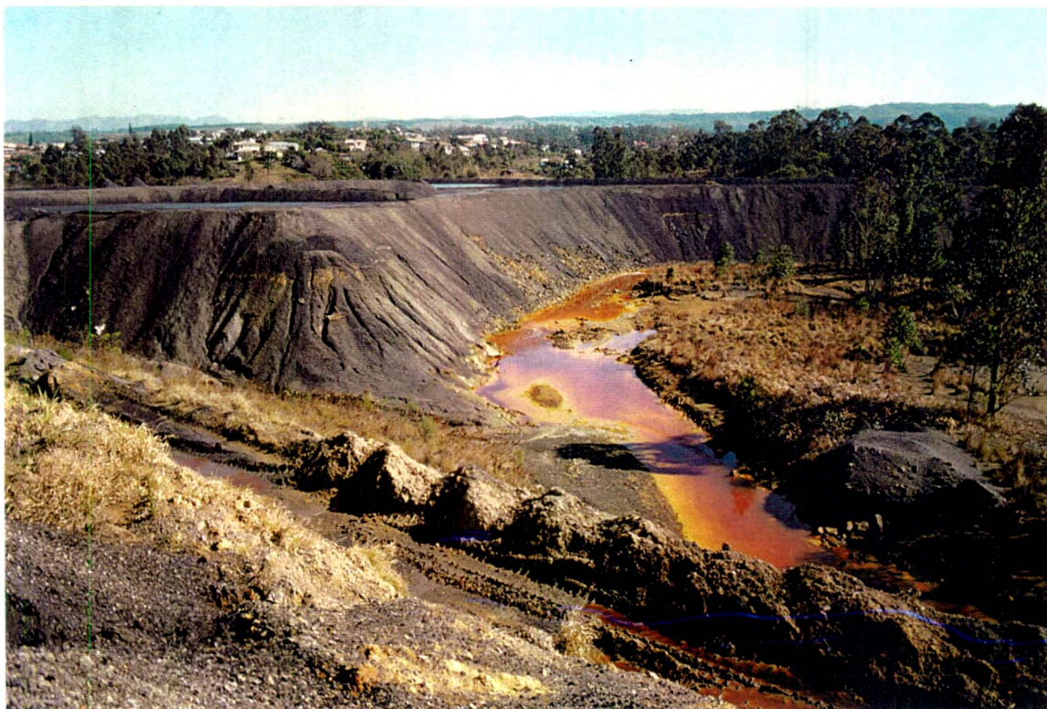
Figura 12: Deposição de rejeitos piritosos e bacias de deposição de finos provenientes do beneficiamento de carvão mineral em área de preservação permanente, margens do Rio Sangão, distrito de Rio Maina, município de Criciúma. A mineração de carvão iniciou nesse local no ano de 1945 e a usina de beneficiamento foi instalada em 1975 (informações do escritório DNPM - Criciúma). Foto cedida pela FATMA, de autoria de Norberto Cidade.
