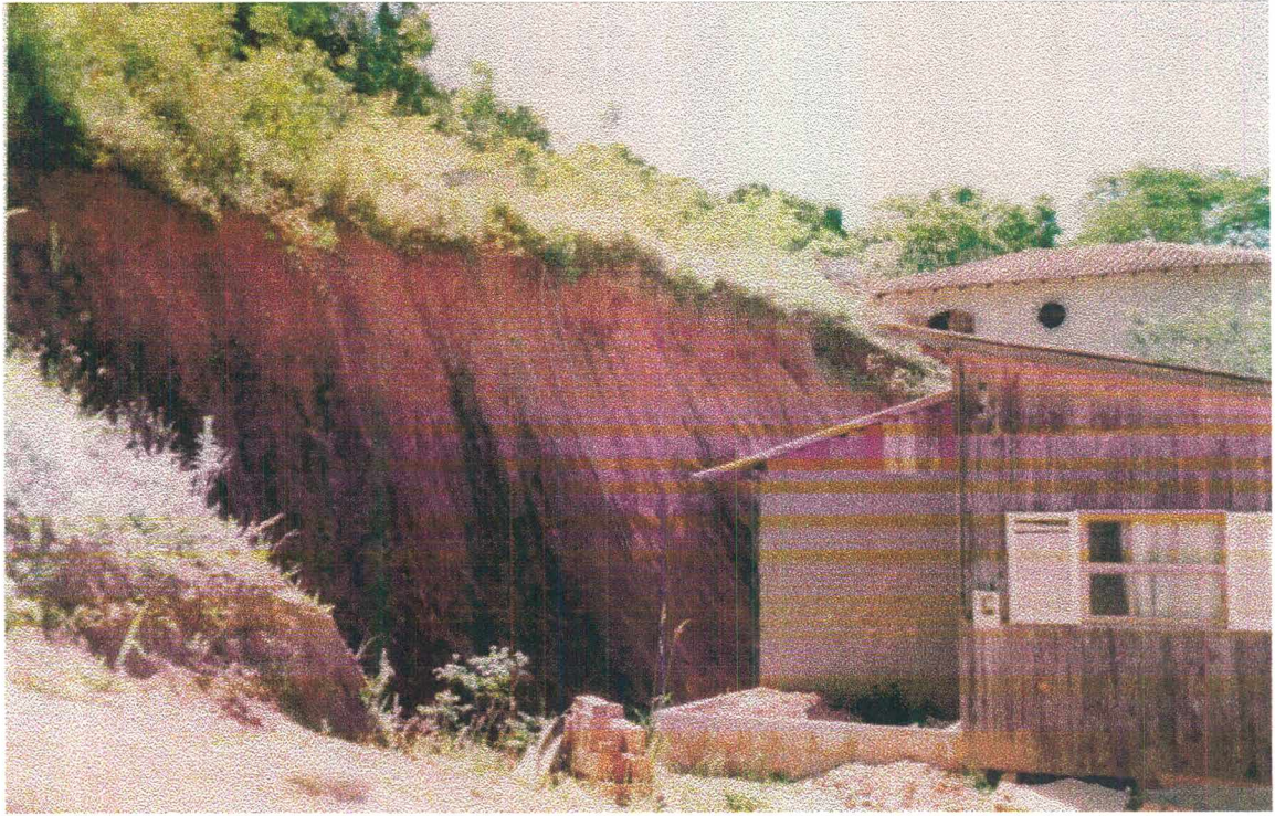
Figura 6.4: Detalhe da ocupação na servidão Casemiro Elesbão, mostrando um corte profundo no manto de alteração de granito
