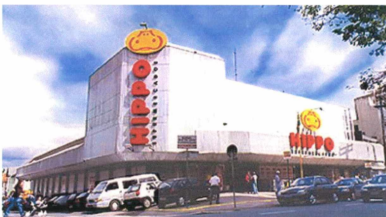
Figura 7 Foto do Hippo Supermercados Ltda. (vista lateral).
