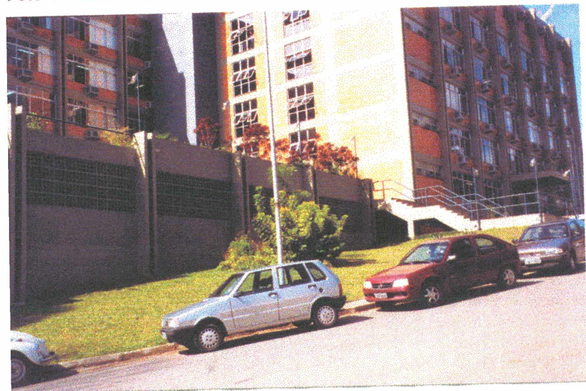
Foto 2 – Vista parcial do CELTA
