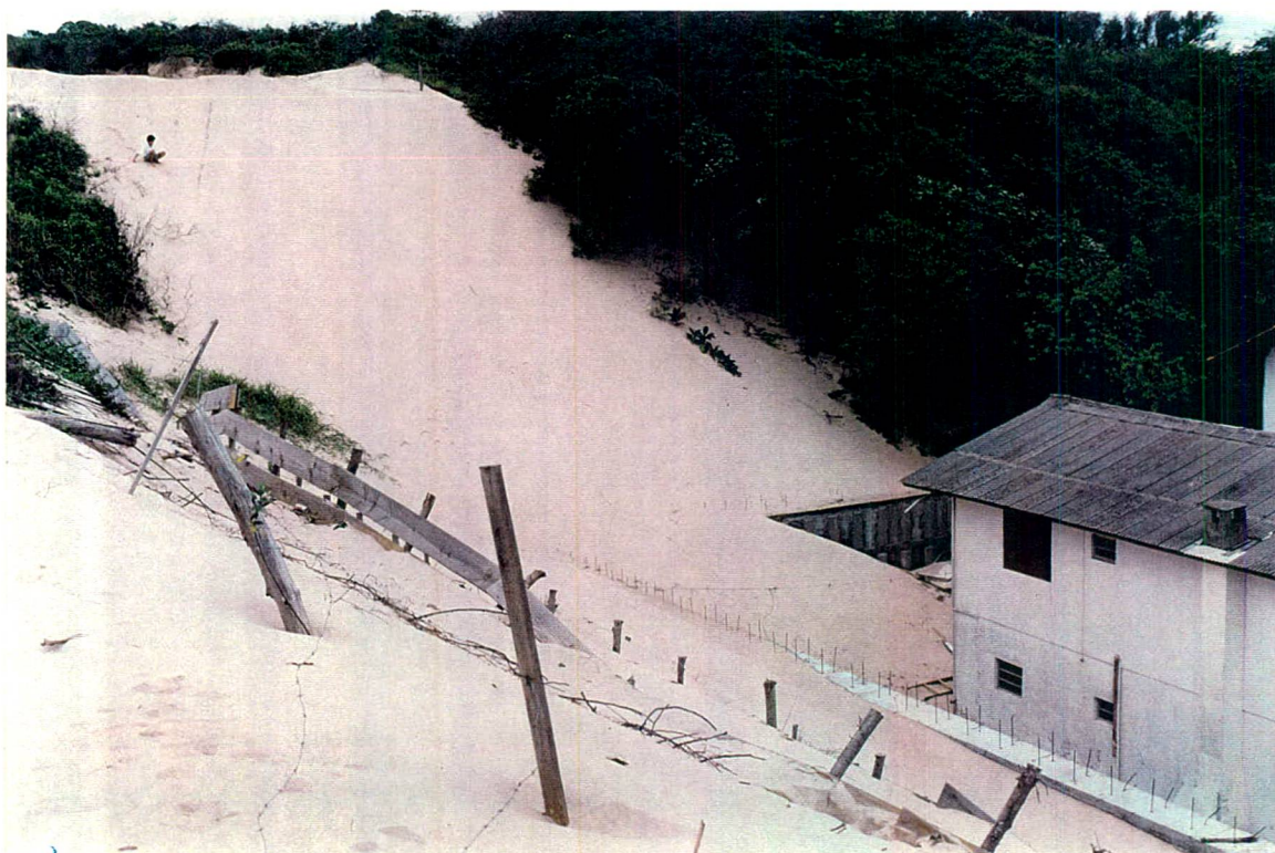
FIG. 18 - AVANÇO DAS DUNAS SOBRE AS CASAS SITUADAS À NOROESTE DO CAMPO DE DUNAS ATIVAS SANTINHO-INGLESES.
