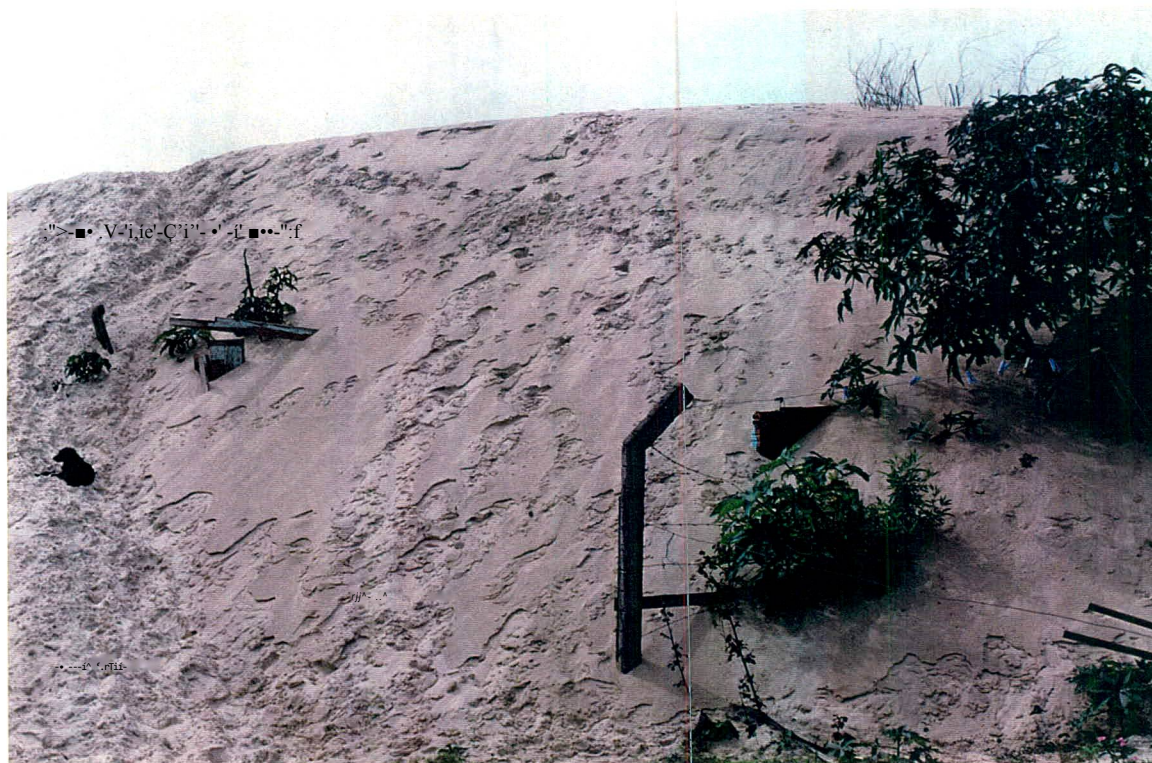
FIG. 36 - SOTERRAMENTO DE CASAS SITUADAS EM FRENTE AO CAMPO DE DUNAS ATIVAS MOÇAMBIQUE-INGLESES, Rua Adão dos Reis - 1996
