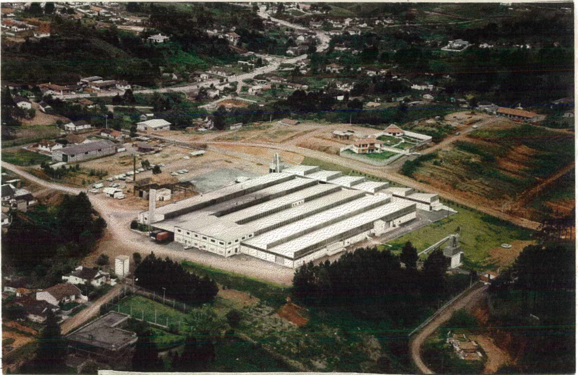
Vista aérea da nova fábrica da Móveis Leopoldo Uma das pioneiras
