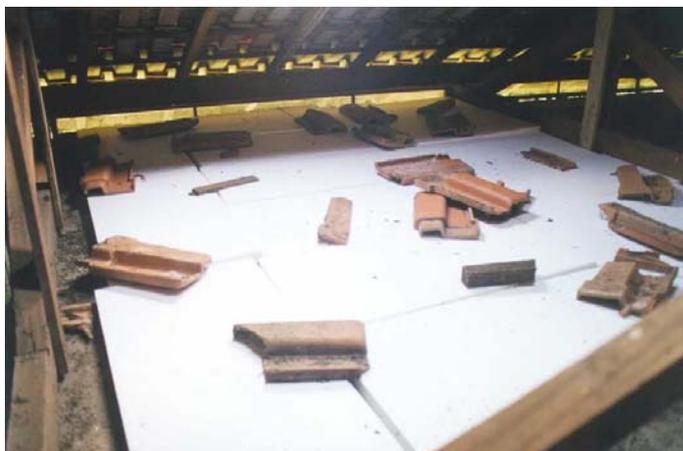
Figura 27 - Vista do isolamento na laje de cobertura.
