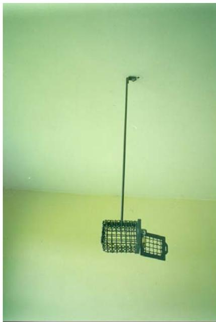
Figura 24 - Vista da gaiola de suporte para os sensores
