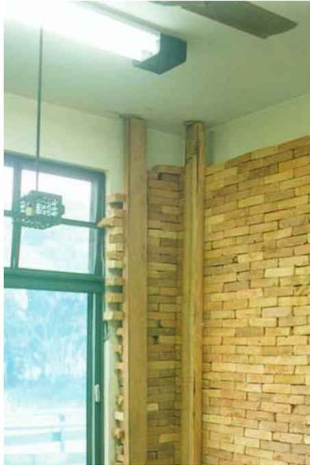
Figura 29 - Vista dos tijolos empilhados em  $\frac{1}{2}$  vez.
