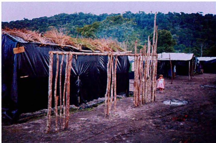
Estrutura da futura varanda
