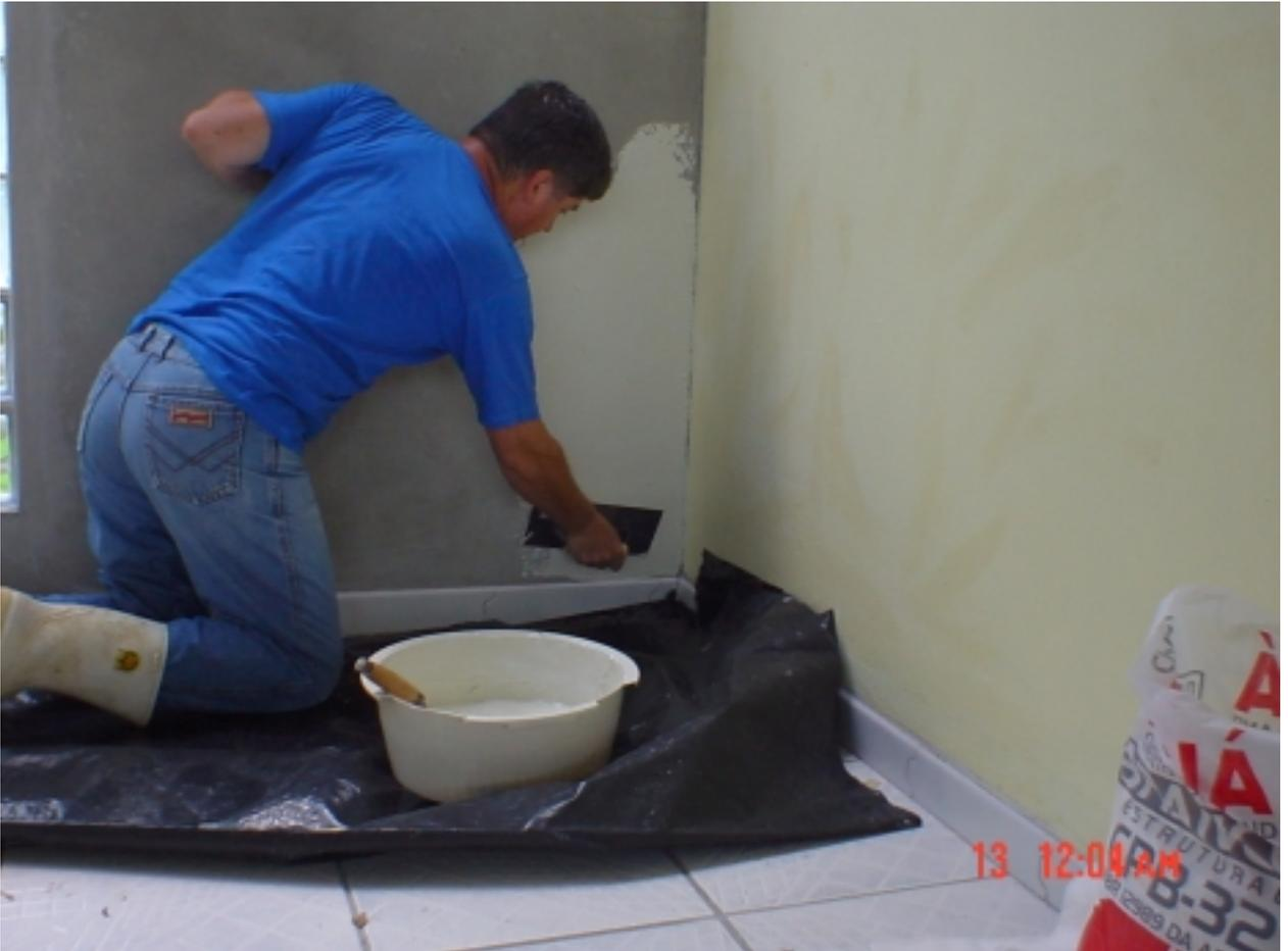
Figuras 25: Mostra a passagem da pasta de Escariola (cal e cimento) sobre a superfície.
