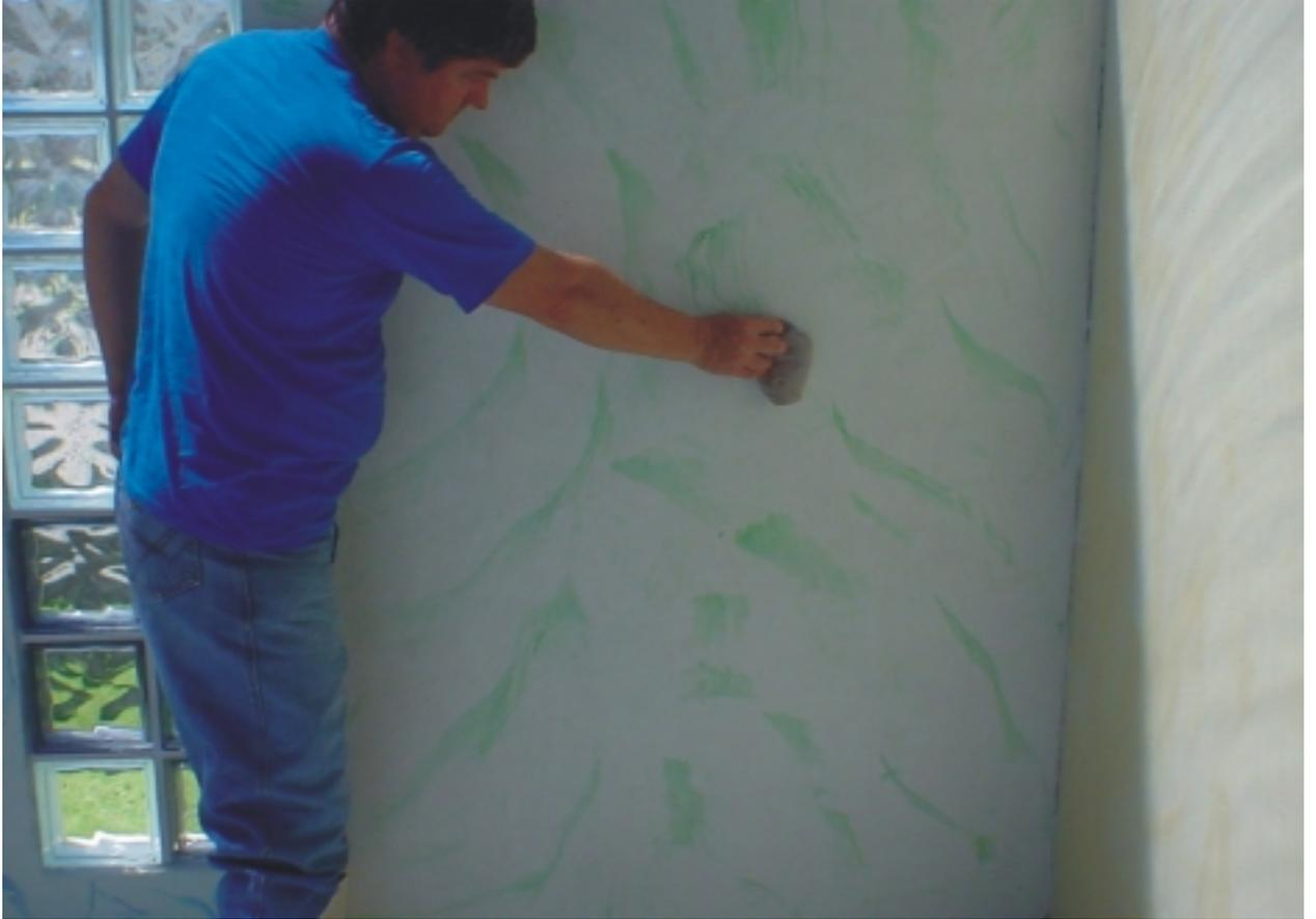
Figura 29: Mostra a passagem do talco sobre a superfície.
