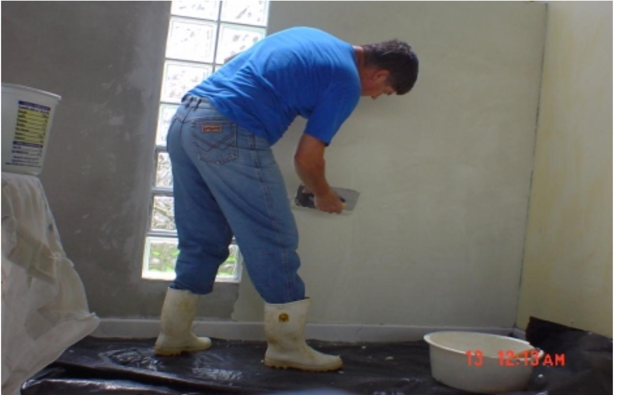
Figura 26: Mostra a passagem da pasta de Escariola (cal e cimento) sobre a superfície.
