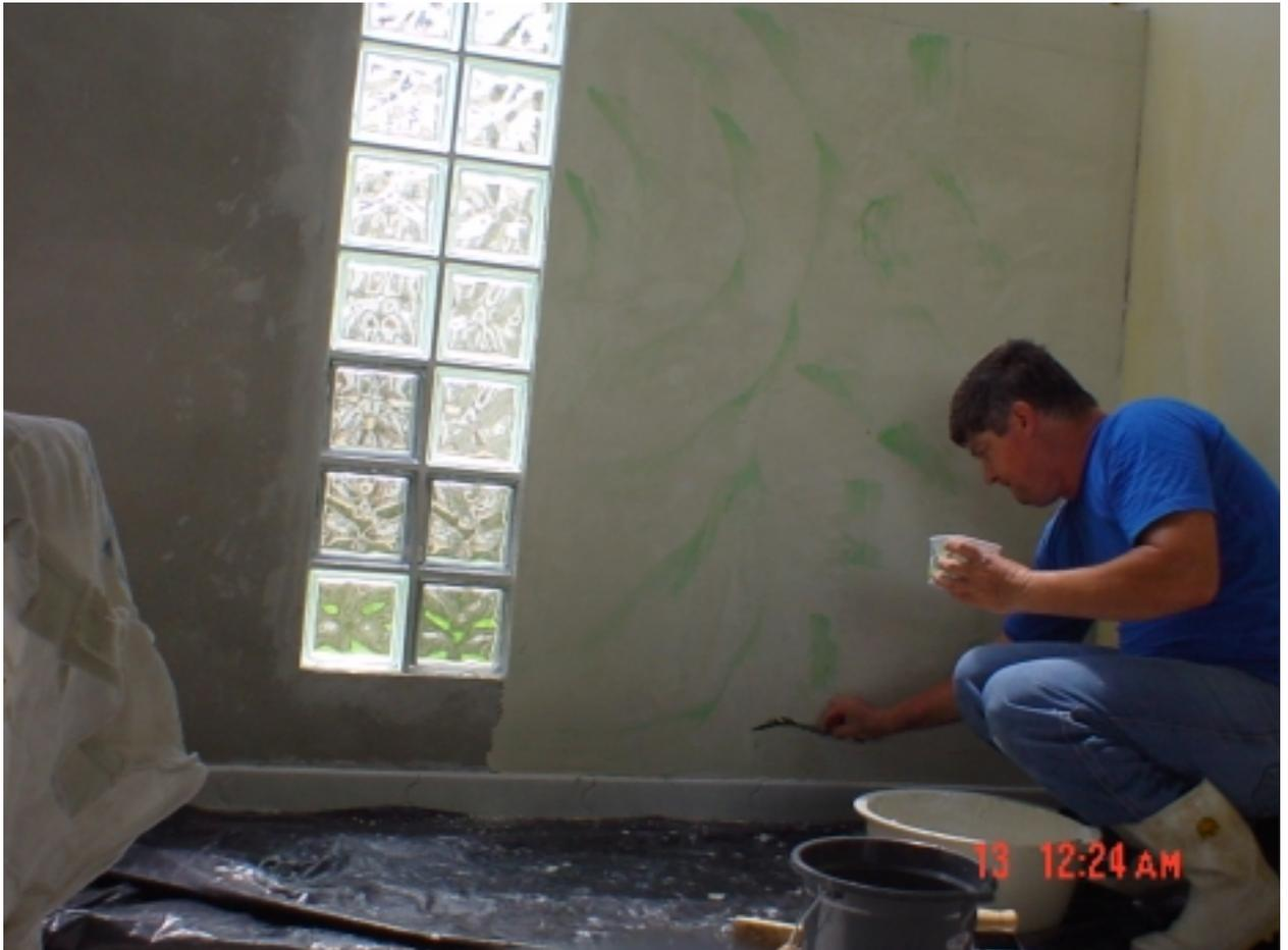
Figura 28: Confeção da pintura com auxílio de uma pena de galinha.
