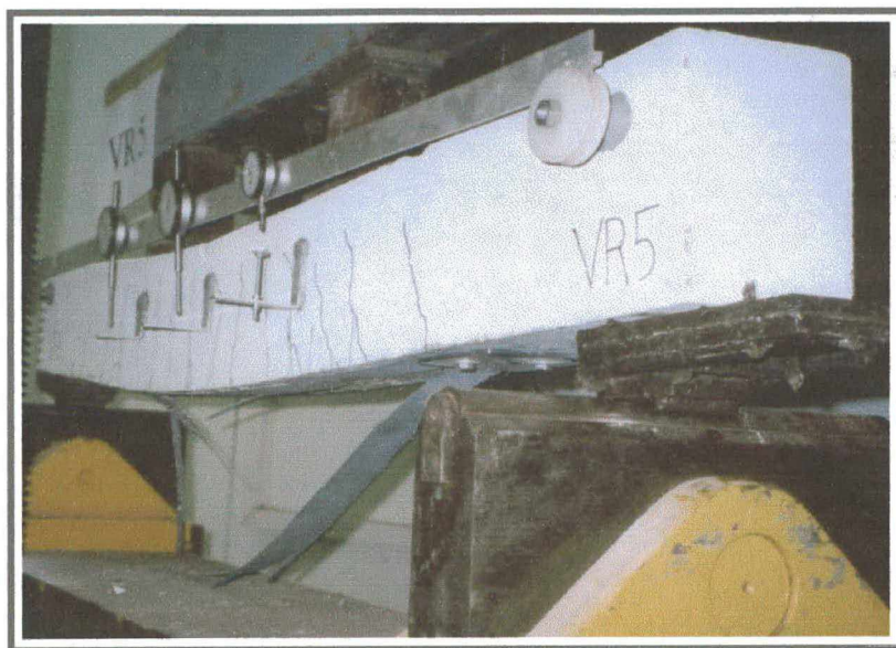
Figura 6.19 – Detalhe da ruptura da manta de fibra de carbono na viga VR5
