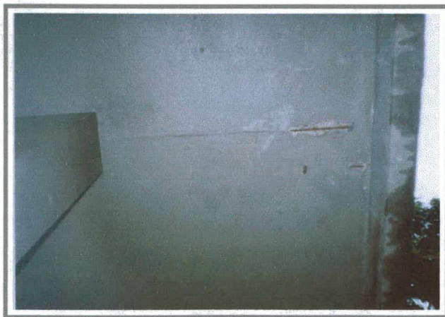
Figura 2.5 – Corrosão em marquise
