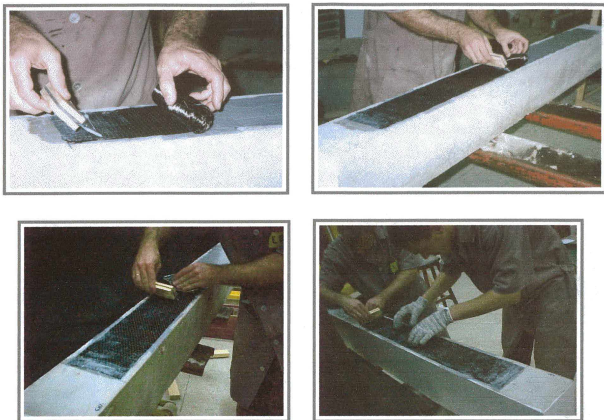
Figura 5.19 – Aplicação da manta de fibra de carbono
