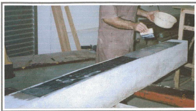
Figura 5.21 – Detalhe da aplicação da segunda camada de resina
