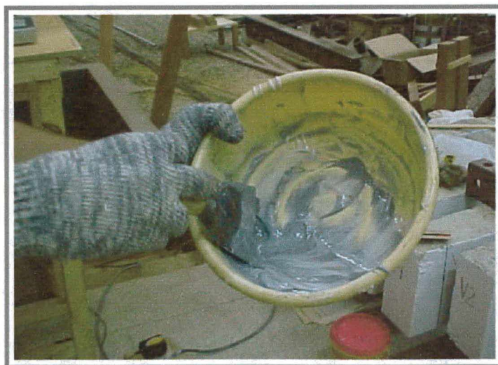
Figura 5.17 – Mistura manual da resina a base de epóxi
