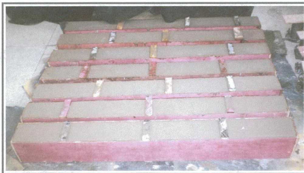
Figura 5.14 – Detalhe das vigas após a moldagem
