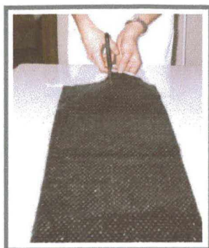
Figura 5.16 – Corte da manta de fibra de carbono
