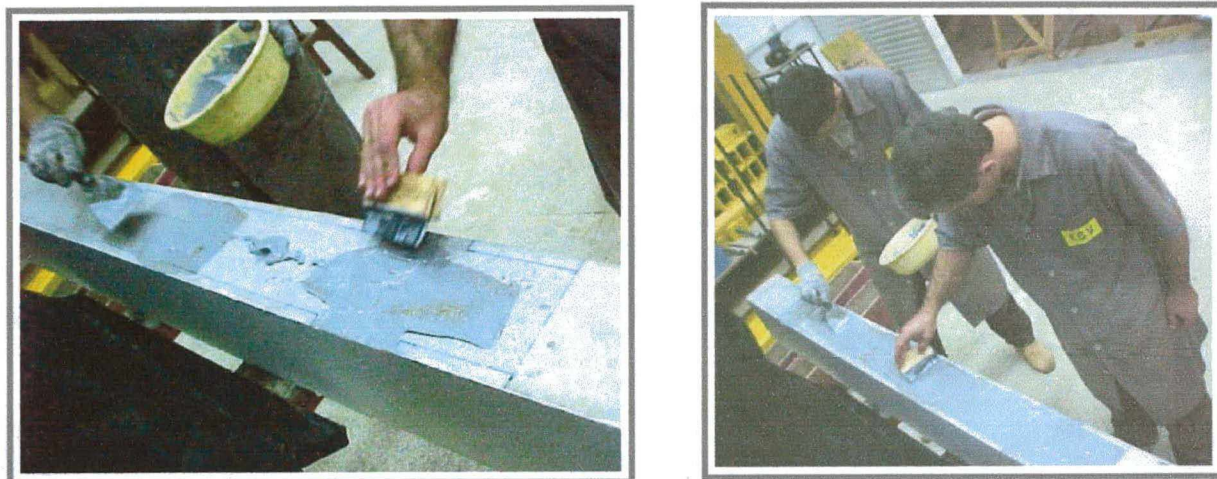
Figura 5.18 – Aplicação da resina sobre o substrato de concreto
