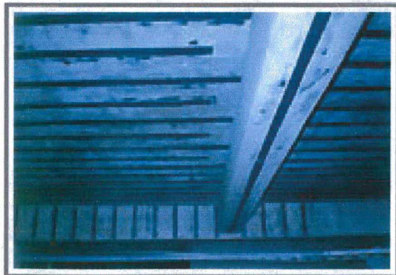
Figura 3.7 – Reforço à flexão em laje e viga de concreto armado por meio da colagem de chapas de aço
