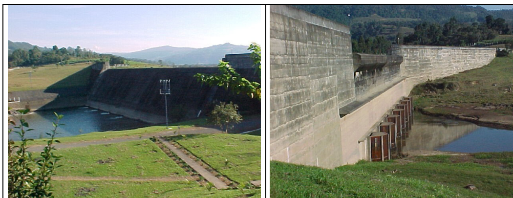
FIGURA 1.6 – FOTO DA BARRAGEM DE CONTENÇÃO, LOCALIZADA NO MUNICÍPIO DE TAIÓ, NO ALTO VALE DO ITAJAÍ. À ESQUERDA PODE SER VISTO O LADO DE JUSANTE COM O VERTEDOURO E PARTE DE SUA ÁREA DE INUNDAÇÃO. À DIREITA VÊ-SE A FACHADA MONTANTE DO BARRAMENTO, COM A PARTE SUPERIOR DO VERTEDOURO E ALGUNS DOS SEUS COMPONENTES, COMO AS SUAS 7 COMPORTAS, PARA O CONTROLE DO ESCOAMENTO DAS ÁGUAS.
