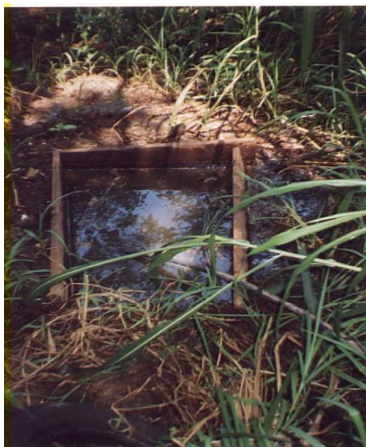
Figura 4: Poço de coleta de líquidos percolados, utilizados no experimento, situado na base do aterro de lixo de Florianópolis.
