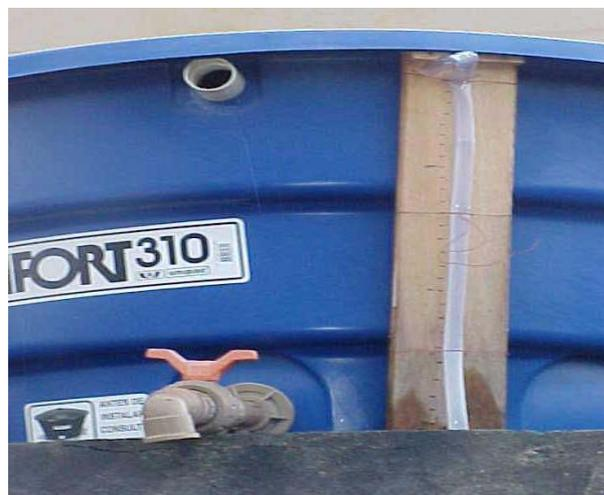
FIGURA 3.6 – PIEZÔMETRO, TUBO LADRÃO, SAÍDA DE ÁGUA DO RESERVATÓRIO DO PRÉDIO ENS
