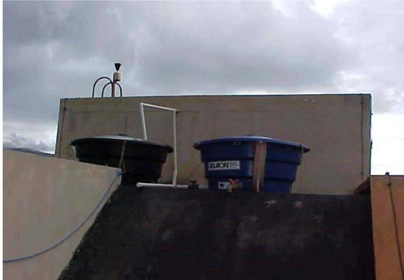
FIGURA 3.8 - FOTO DO SISTEMA CAPTAÇÃO DE ÁGUA DE CHUVA NO PRÉDIO DA ENS-CTC/UFSC.
