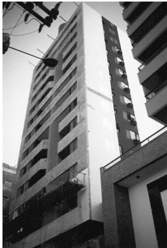
Figura 5.14: Vista do edifício
