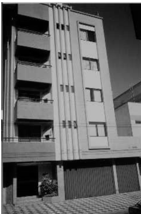
5.22: Vista do edifício
