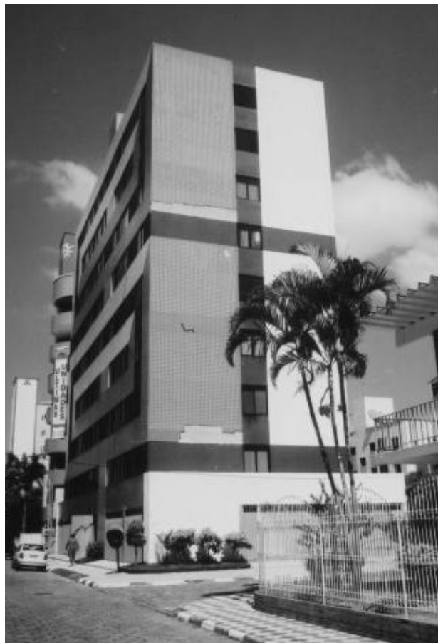
Figura 5.3: Vista do edifício
