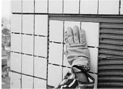
Figura 2.3: Posicionamento inicial da aplicação da placa cerâmica e cordões de argamassa adesiva
