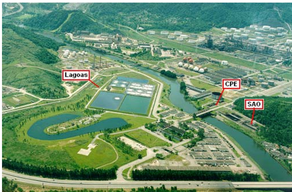
Figura 4 – Vista aérea da estação de despejos industriais da RPBC.
