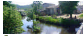
OCUPAÇÃO ILEGAL NAS MARGENS DO RIO TAVARES
