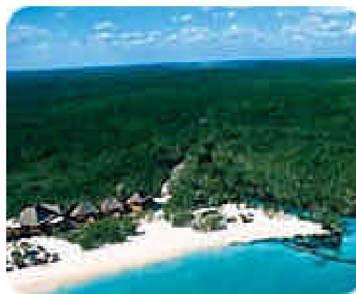
Figura 10: Vista panorâmica do PE Três Rios
