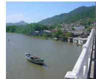
OCUPAÇÃO ILEGAL DAS MARGENS DO RIO TAVARES
