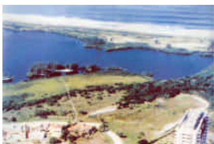
Figura 23: Vista Aérea do Setor Norte Estado Natural
