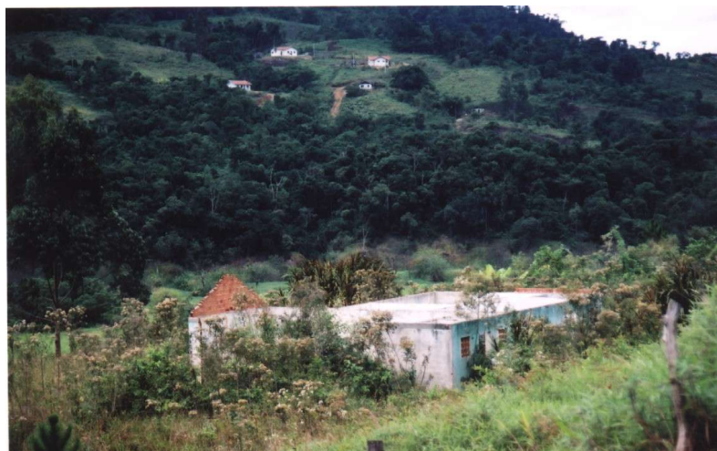
Ruínas da sede antiga pré-barragem
