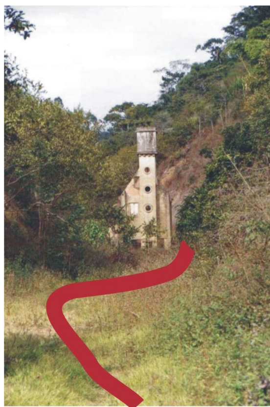
A estrada construída pelos índios
